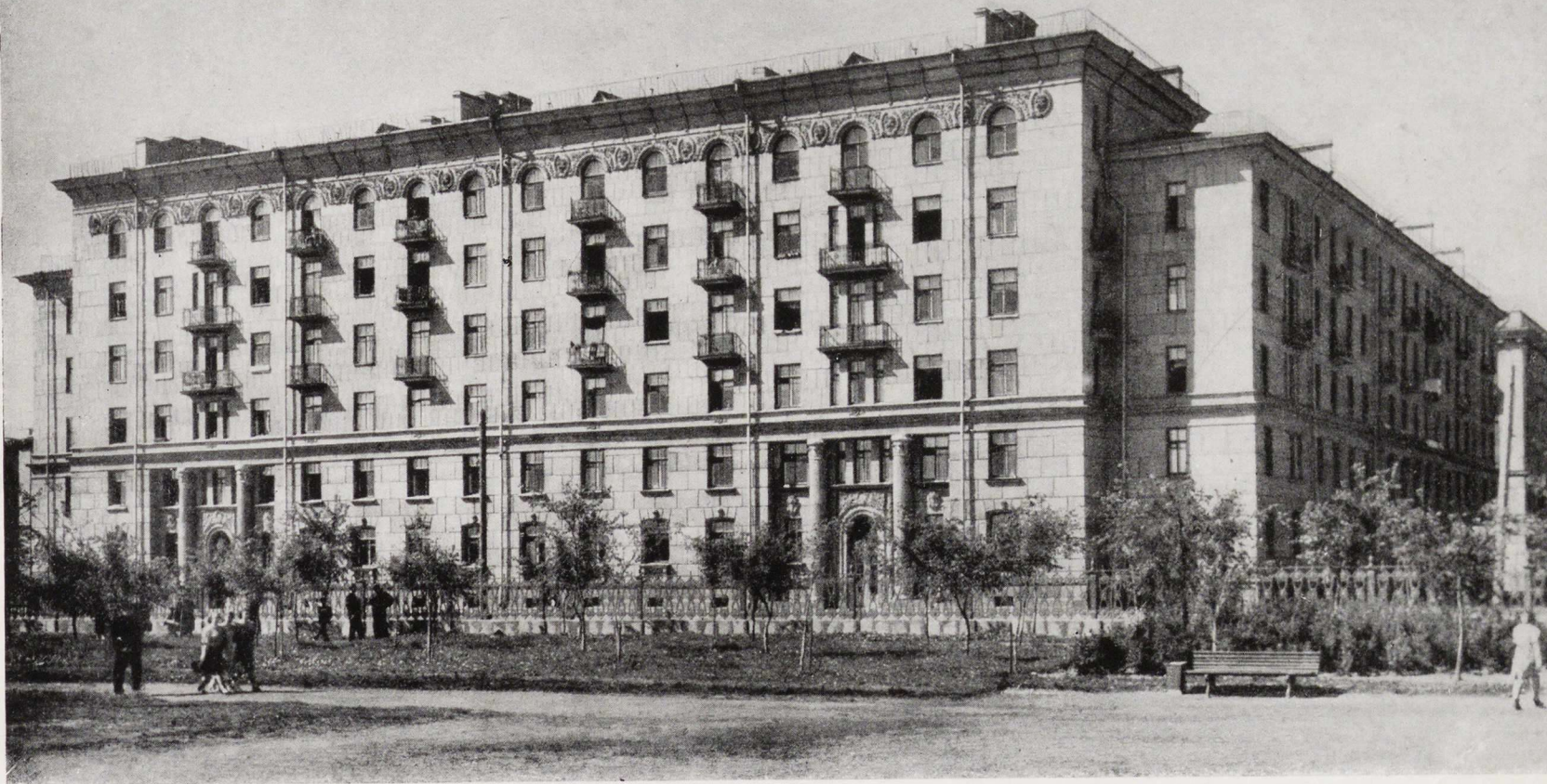
Ленинград. Крупноблочный жилой дом на Кузнецовской улице 20. Архитекторы Б. Журавлев, В. Зотов и инженер Н. Дюбов
