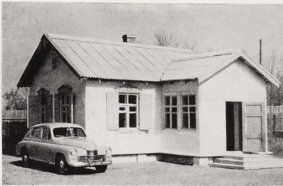
Опытное строительство сборного одноквартирного двухкомнатного сельского жилого дома из камышитовых плит
