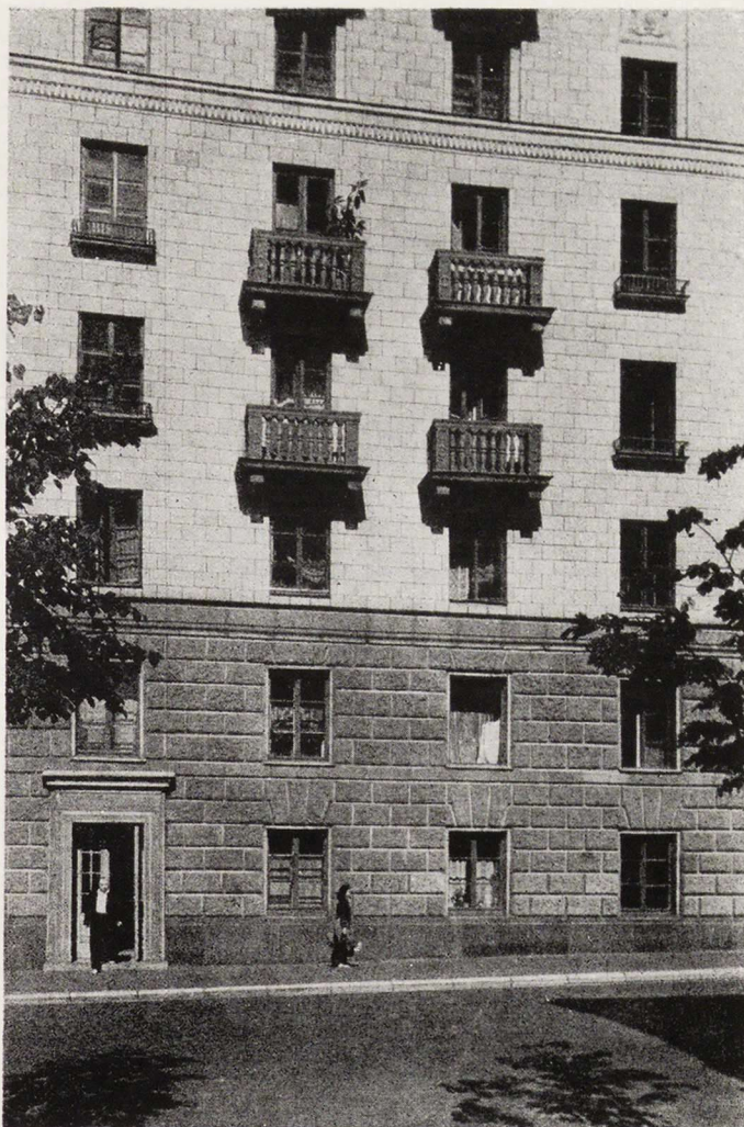
Москва. Жилой дом на 1-й Брестской улице. Фрагмент фасада. Архитектор Н. Степанов и инженер-конструктор Я. Гельман
