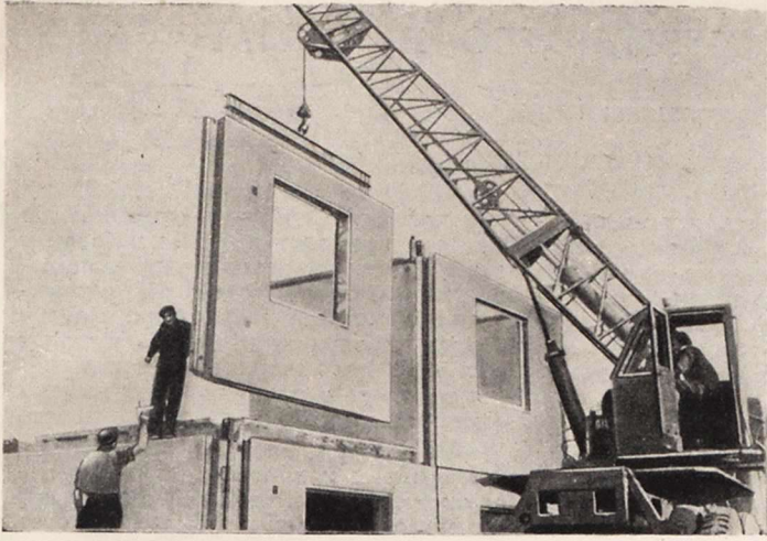
Установка наружной стеновой панели на строительстве здания в Братиславе при помощи 5-тонного автокрана
