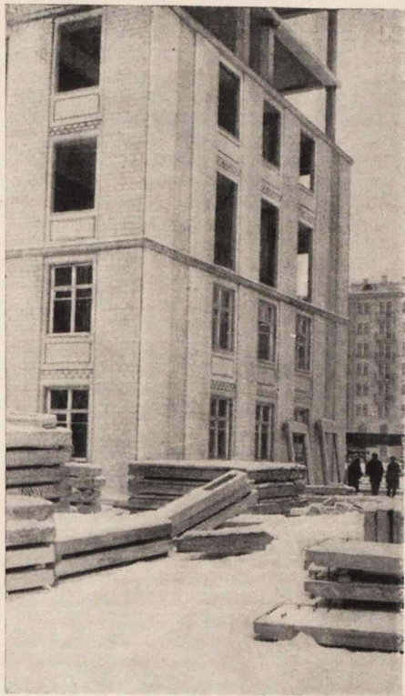
Каркасно-панельный дом в 7-м квартале Ново-Песчаных улиц. Фрагменты фасада
