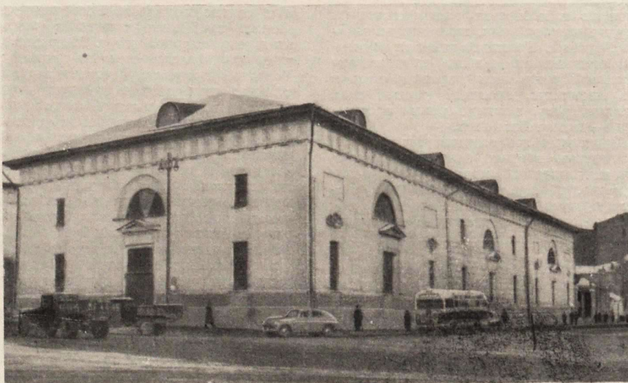
Рис. 5б, Здание 6. Провиантских складов в Москве
