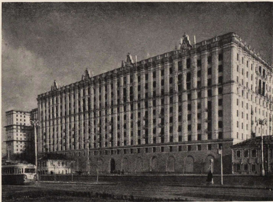
Жилой дом на Ярославском шоссе. Авторы — архитекторы И. Ловейко, С. Ханнин, инженер А. Румянцев
