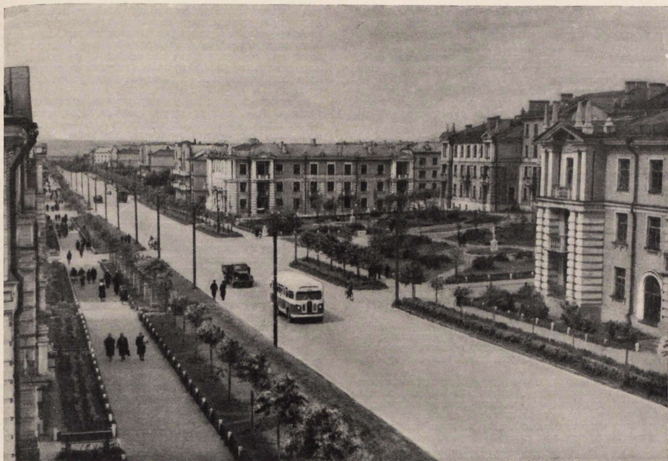
Березники. Жилые дома на улице Пятилетки
