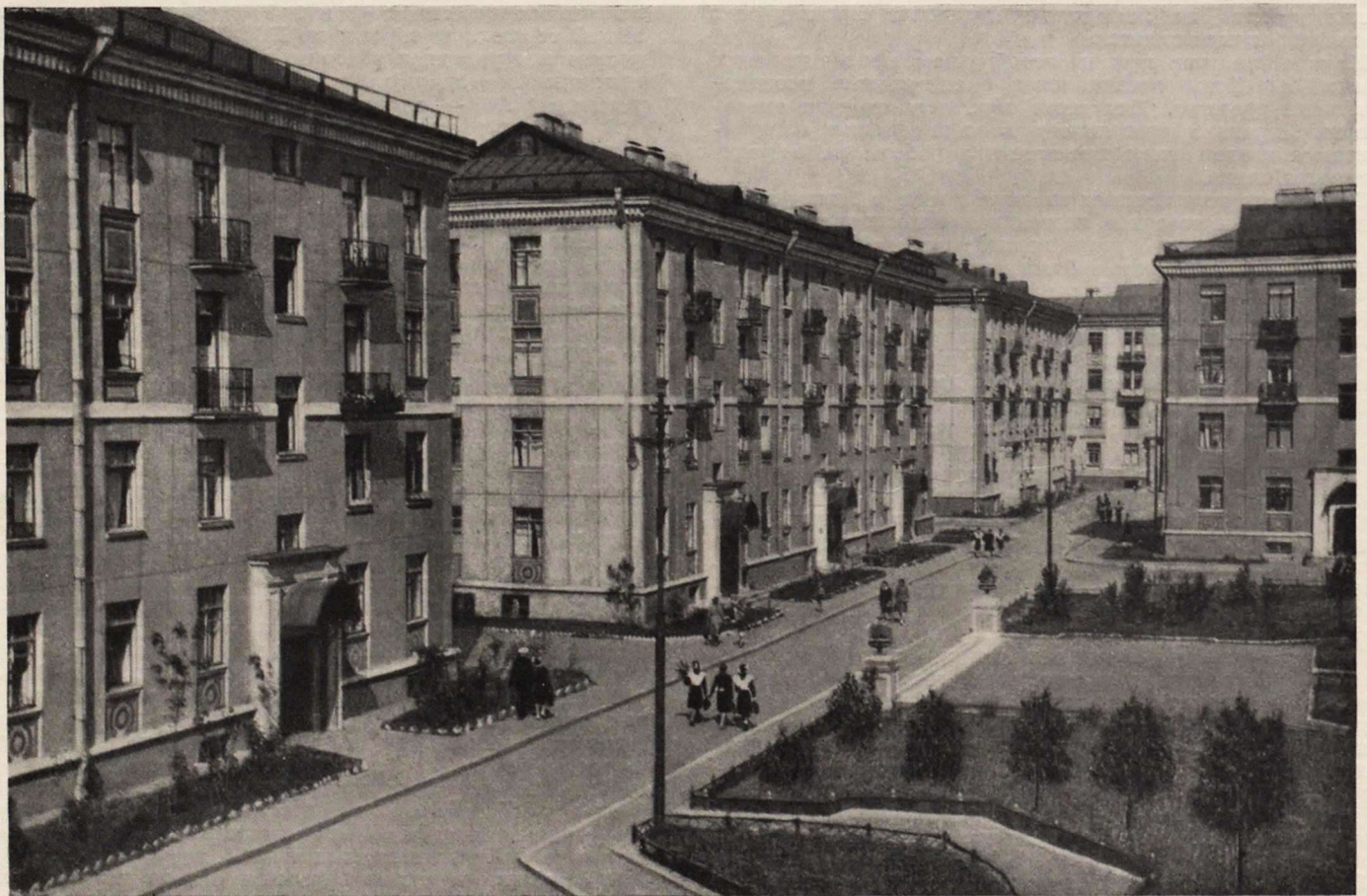
Москва. Крупнопанельные жилые дома на Хорошевском шоссе
