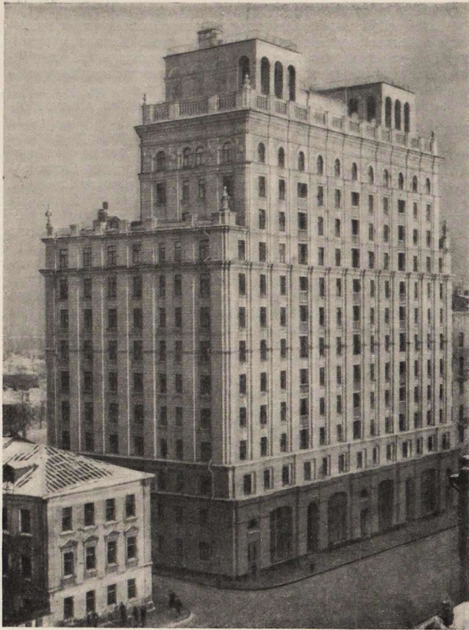
Жилой дом на Вальной улице 6—8. Авторы — архитекторы И. Кастель, Т. Заикин, инженер Ю. Дыховичный
