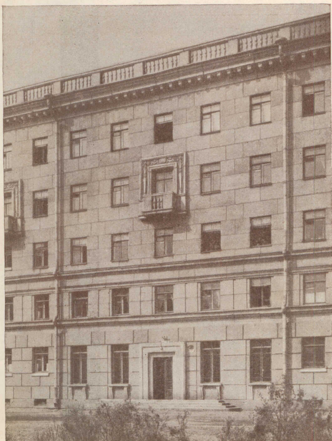
Фрагмент дома с двухрядной разрезкой из трех видов блоков на этаж. Архитекторы Б. Журавлев, А. Кац, А. Сибирияков
