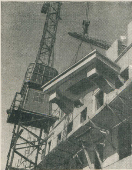
Установка крупноблочного балкона
