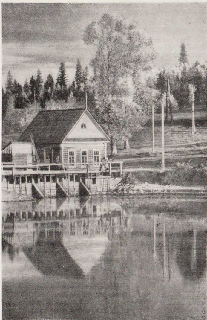
Здание колхозной электростанции. Минская область
