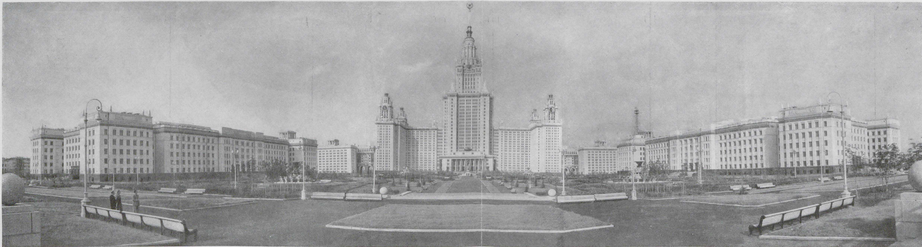
Общий вид здания
