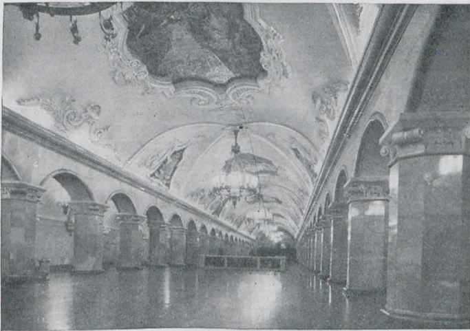
Центральный зал станции Комсомольская—кольцевая
