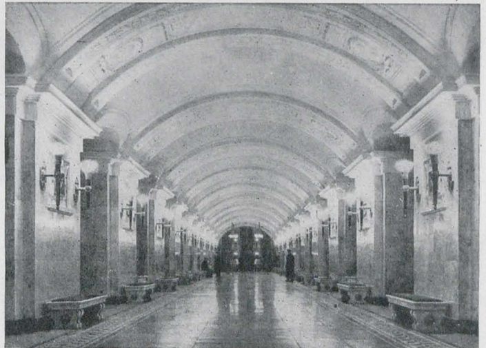
Центральный зал станции Калужская
