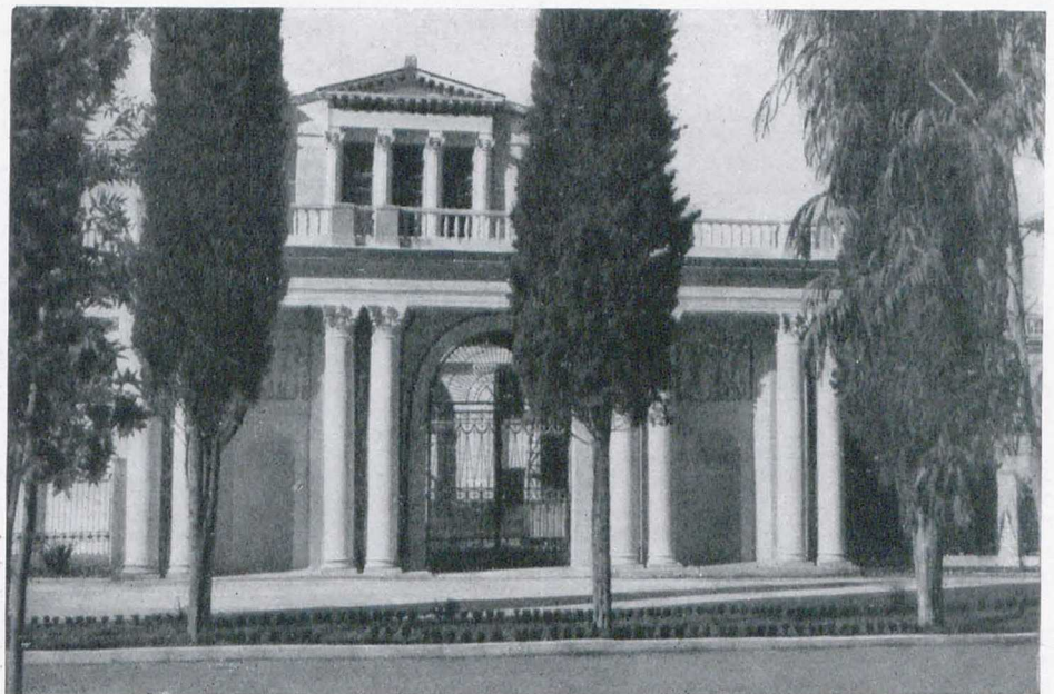
Центральный вход со стороны шоссе
