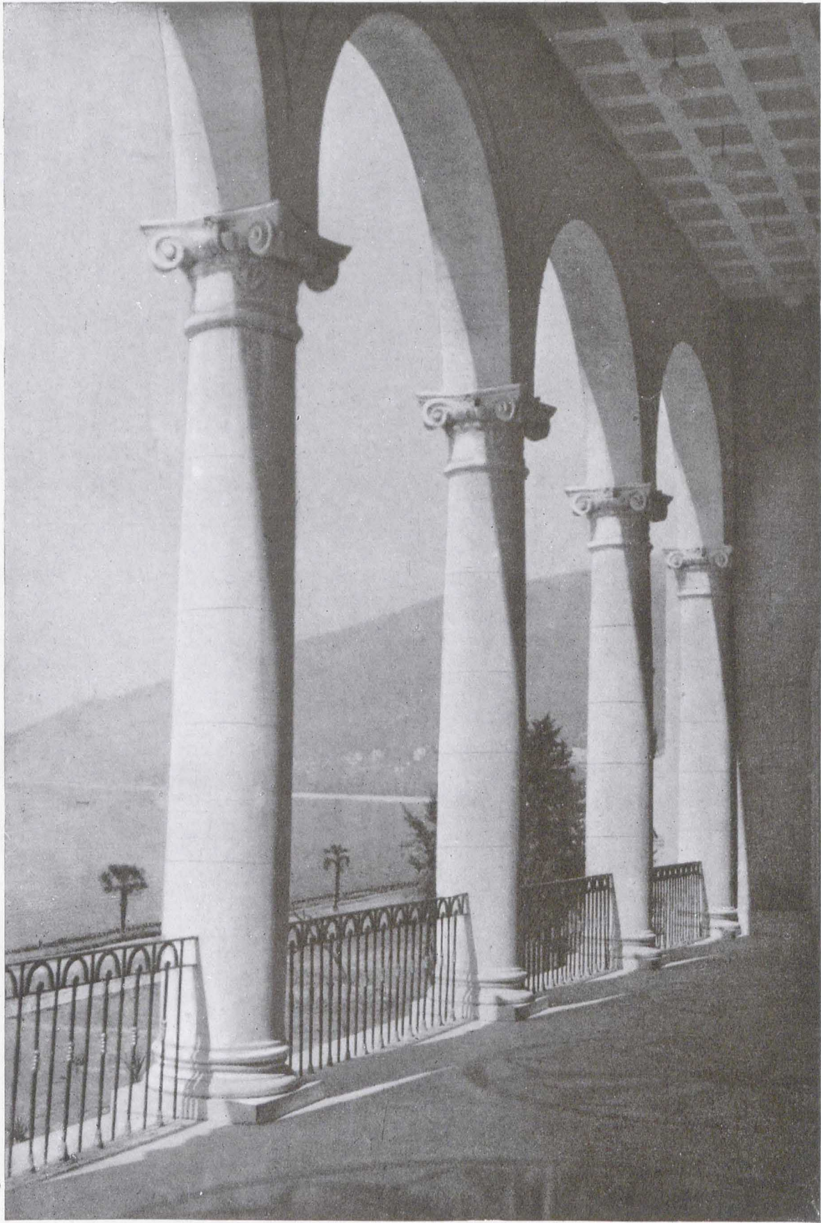
Санаторий в г. Гагре. Корпус столовой. Лоджия
