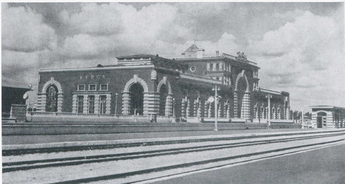
Вокзал в Курске. Общий вид со стороны перрона. Архитектор И. Явейн. II премия
