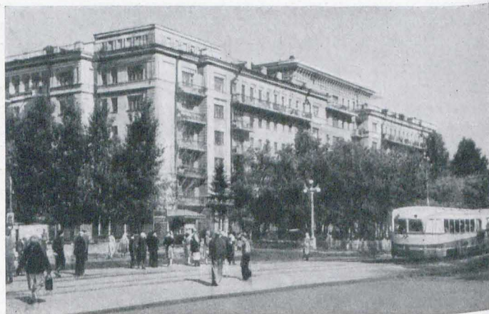
Жилой дом. Архитектор Н. Бровкин
