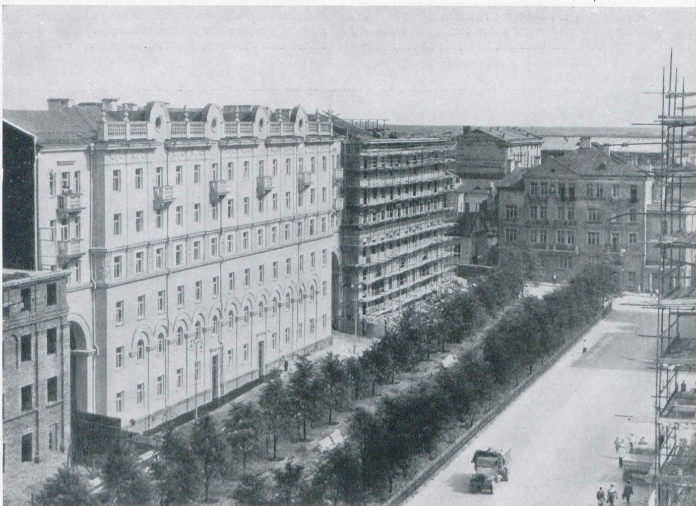
Минск. Строительство жилого дома на улице Ленина. Архитектор Н. Дроздов
