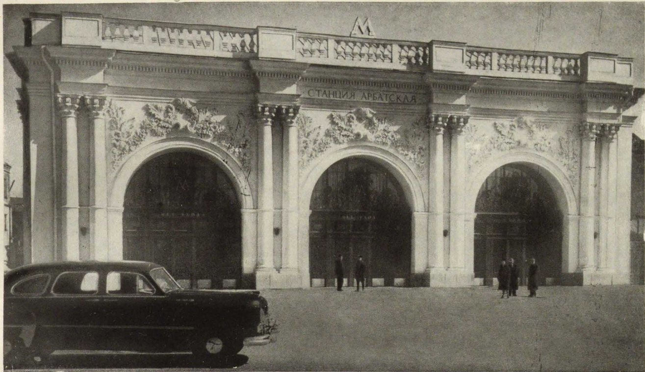
Станция метро «Арбатская». Наземный вестибюль
