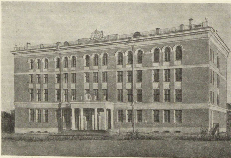
Москва. Типовая школа на 880 учащихся. Архитекторы А. Ростковский, И. Чекалин и Л. Степанова
