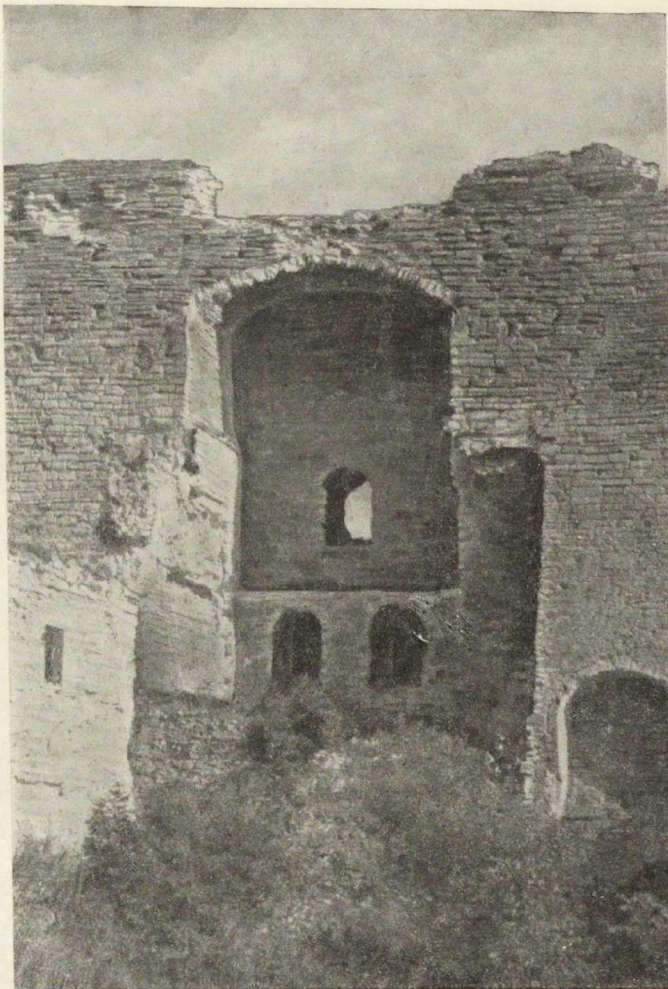
Внутренняя сторона южной башни укреплений Ивангорода 1492 г.
