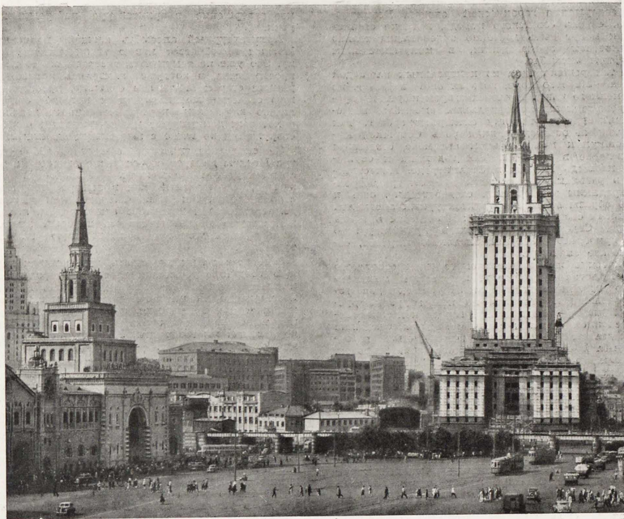
Строительство высотного здания на Комсомольской площади в Москве
