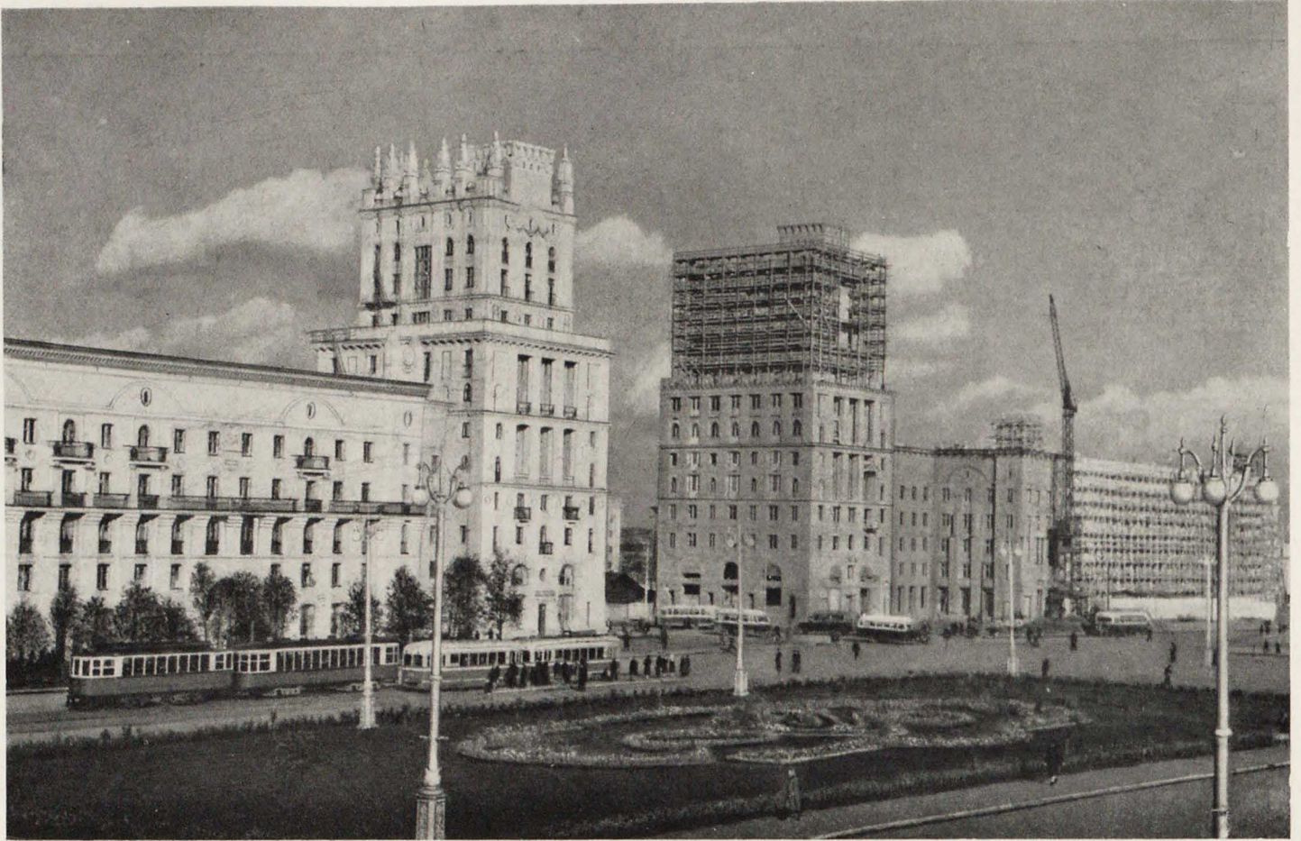
Строительство многоэтажных жилых домов на Вокзальной площади в Минске
