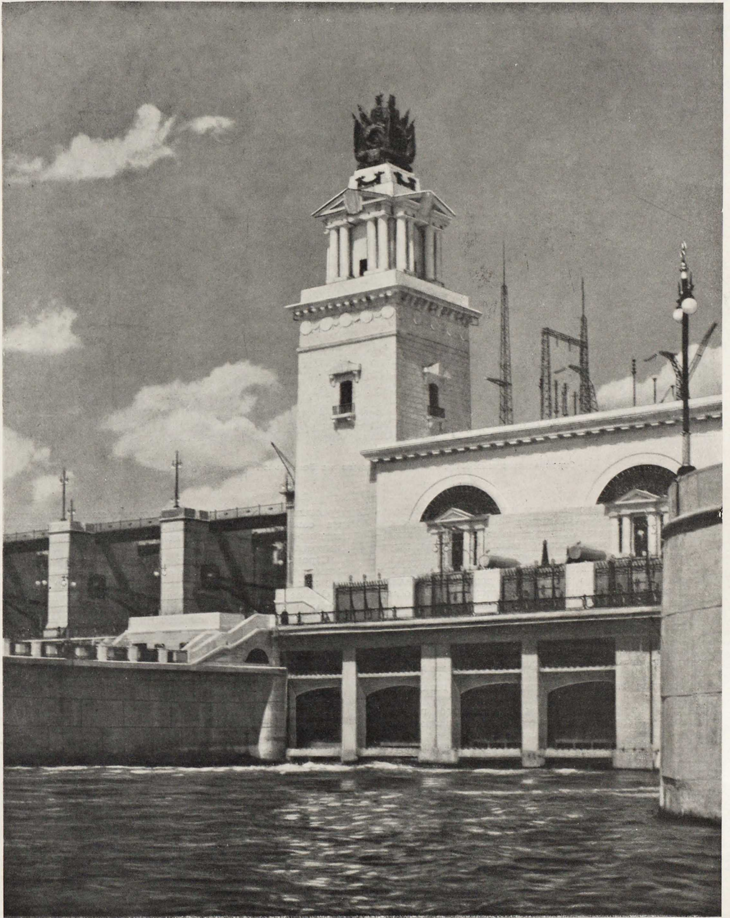
Фрагмент здания Цимлянской гидроэлектростанции
