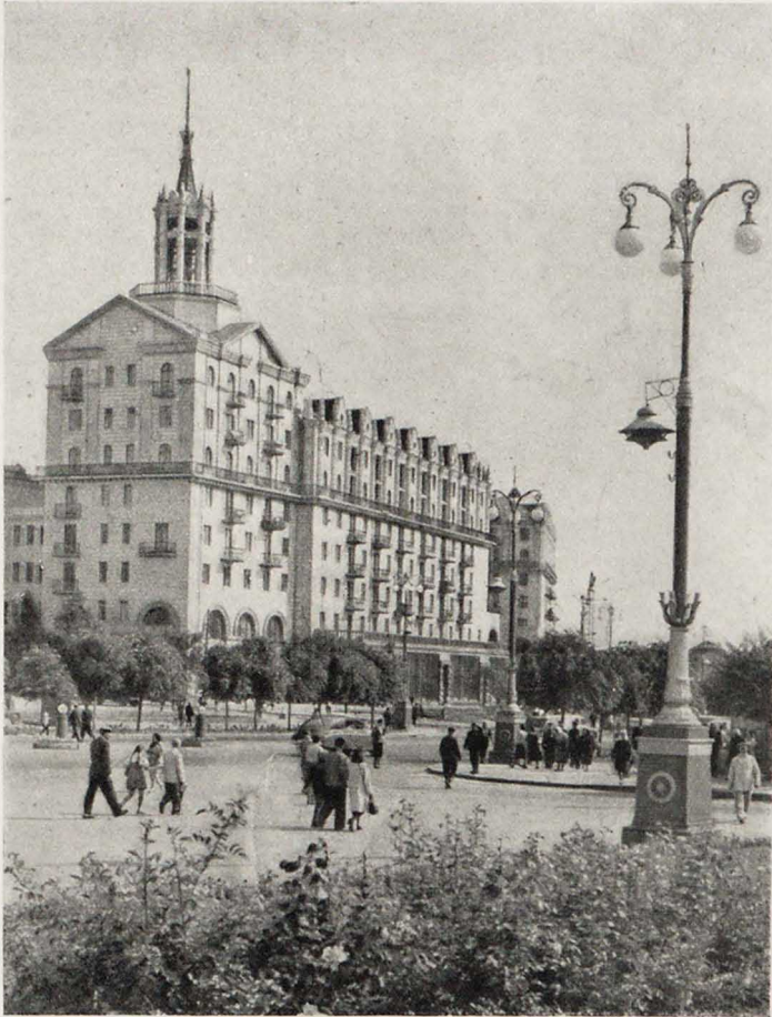
Общий вид жилого дома на Крещатике.
