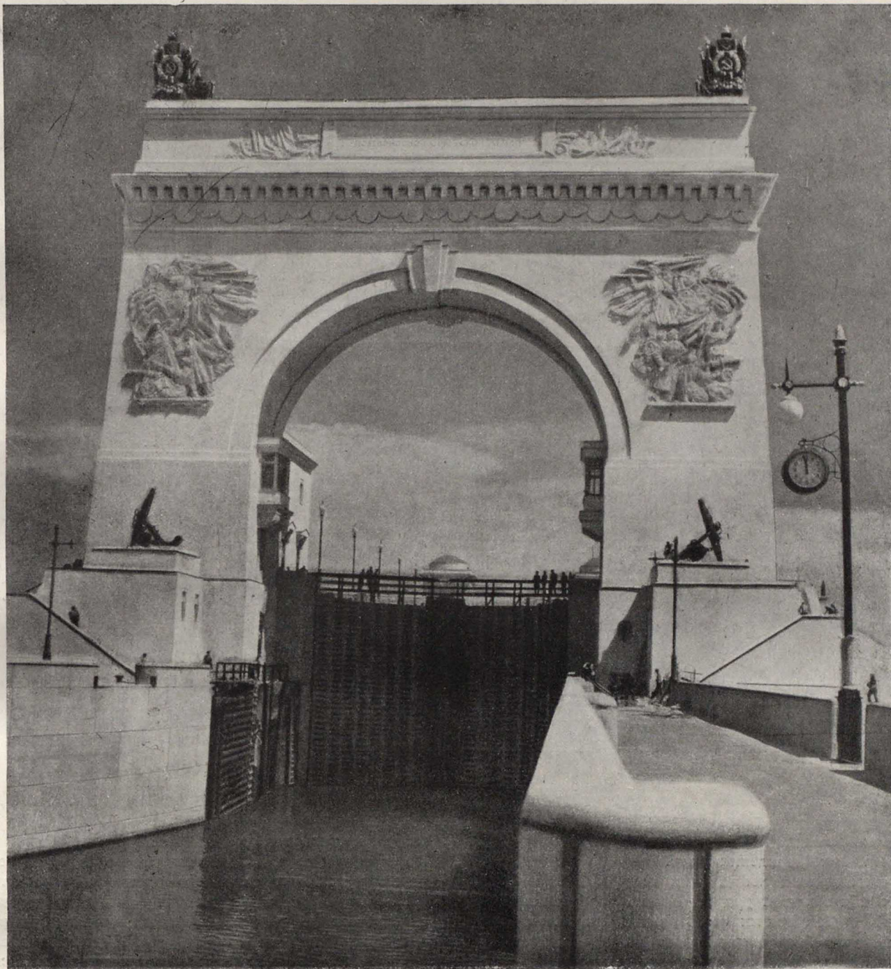
Арка тринадцатого шлюза у входа в канал со стороны Цимлянского моря
