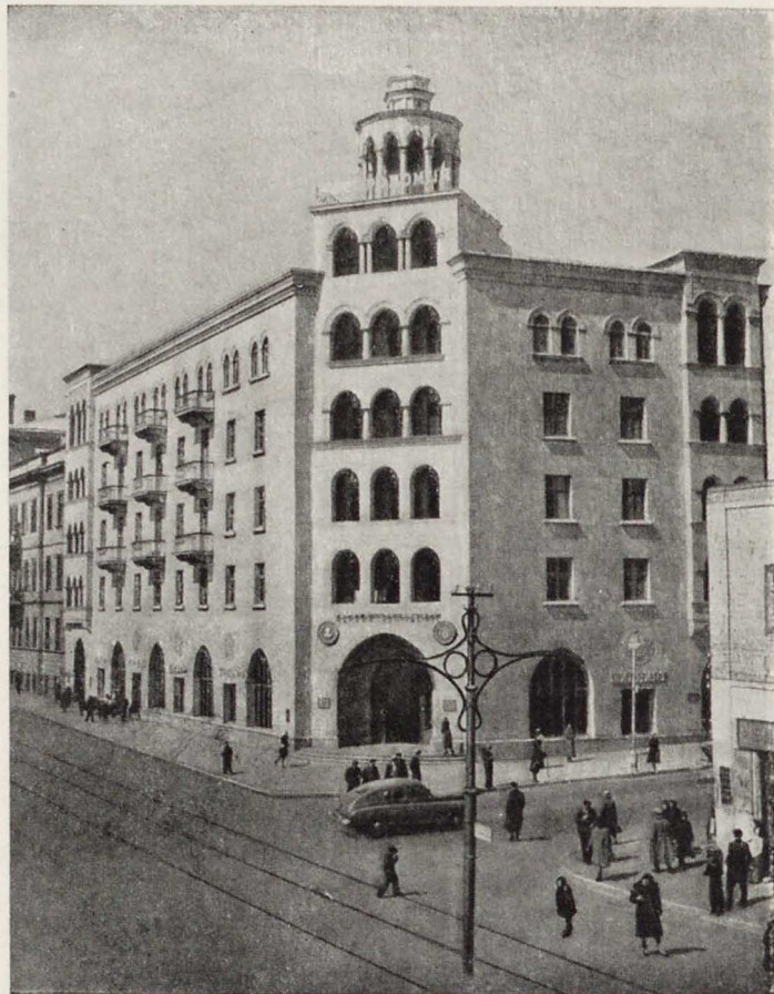
Жилой дом Мингечаургэсстройа в Баку. Архитектор Г. Ализаде
