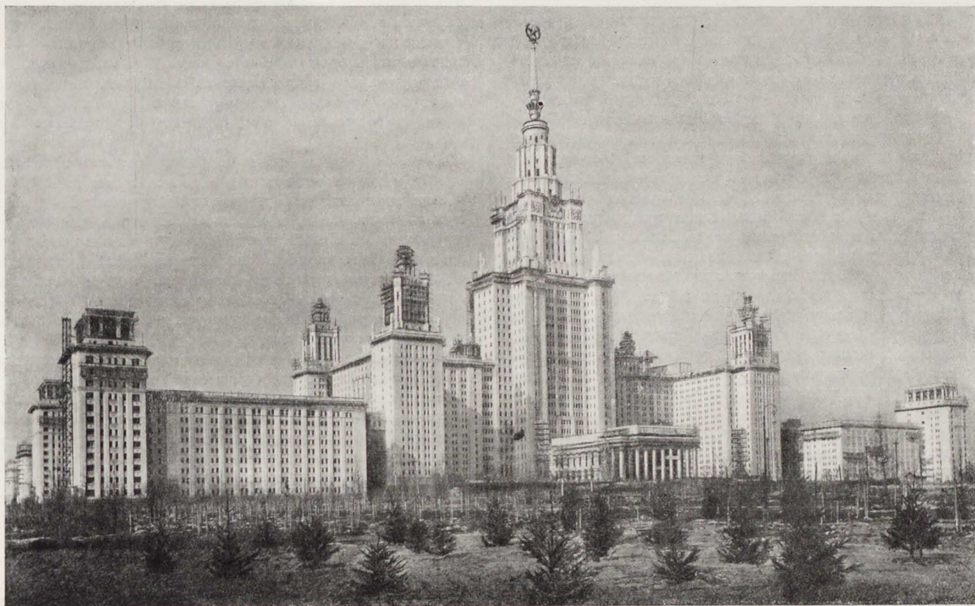
Строительство высотного здания Московского государственного университета
