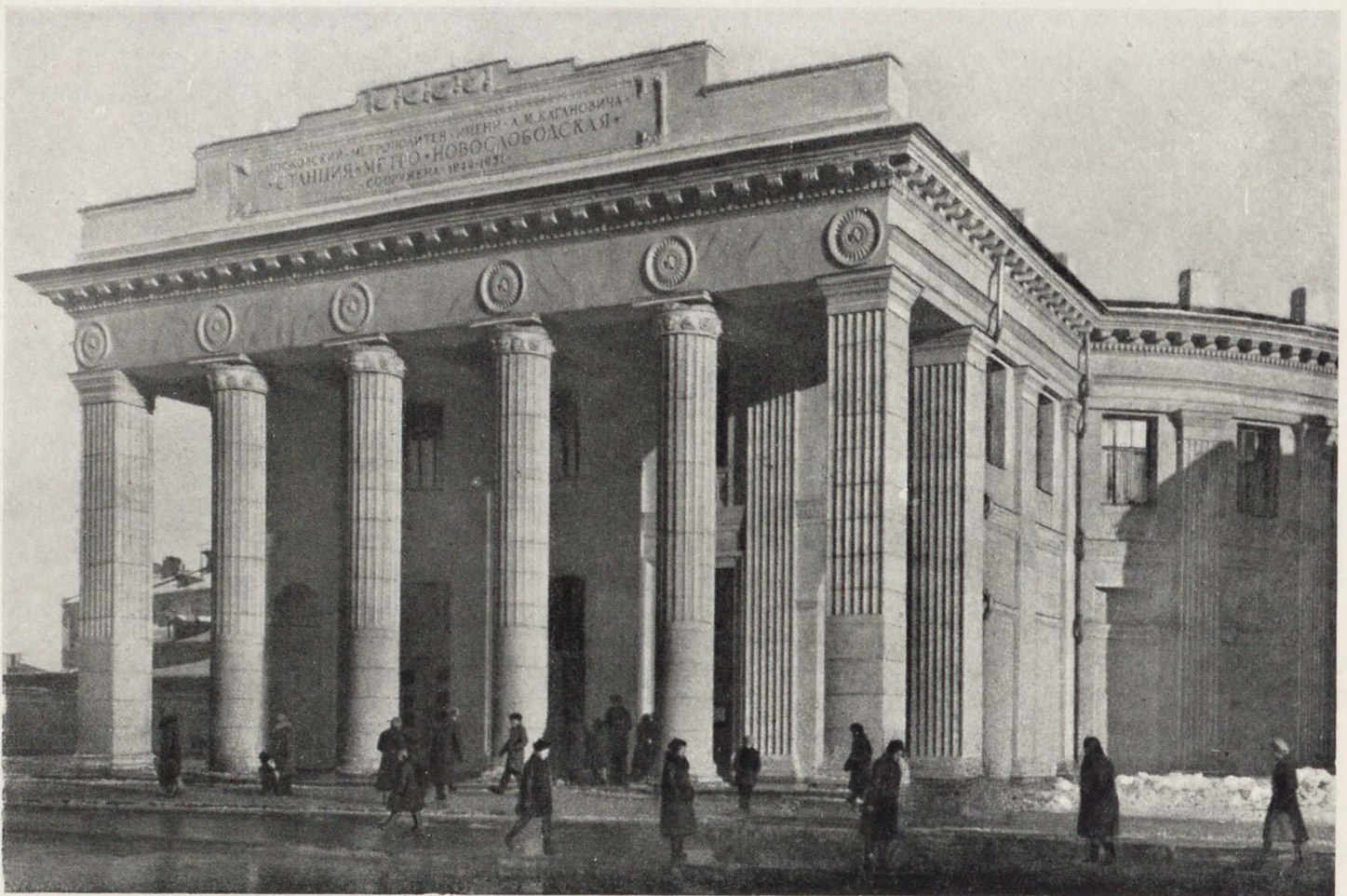
Наземный вестибюль станции «Новослободская». Авторы — архитекторы А. Душкин и А. Стрелков
