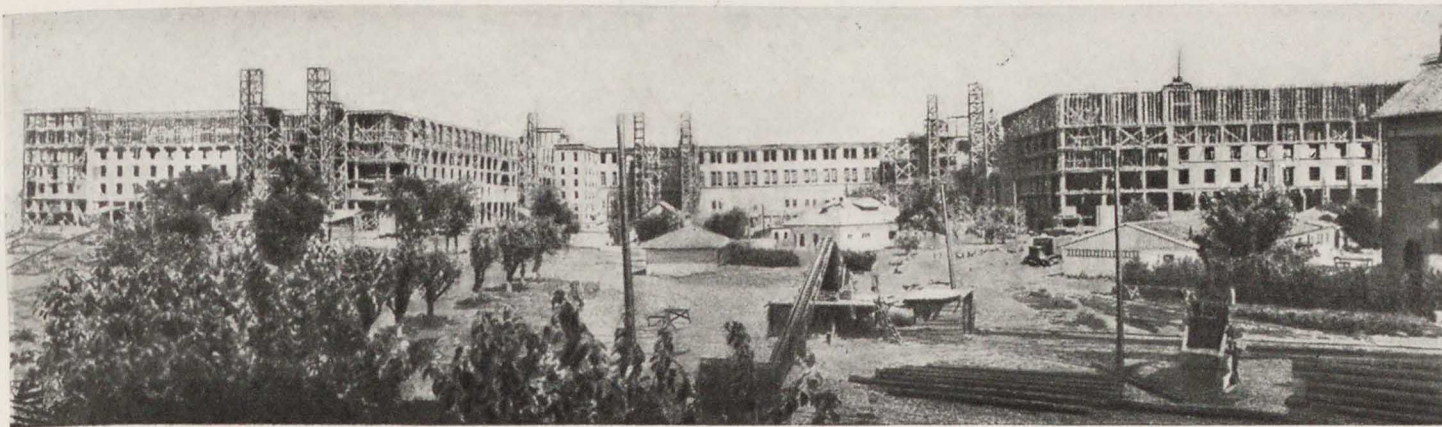
Строительство дома «Скынтейи». Общий вид
