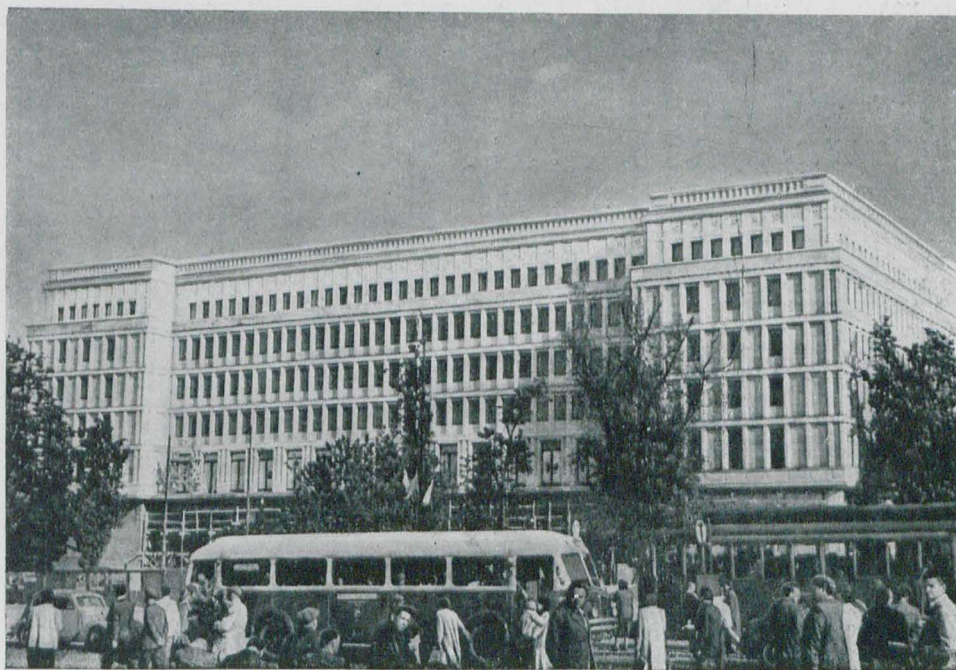
Здание Центрального Комитета Польской объединенной рабочей партии. Архитекторы — Е. Вежбицкий, В. Клышевский и Е. Мокшинский
