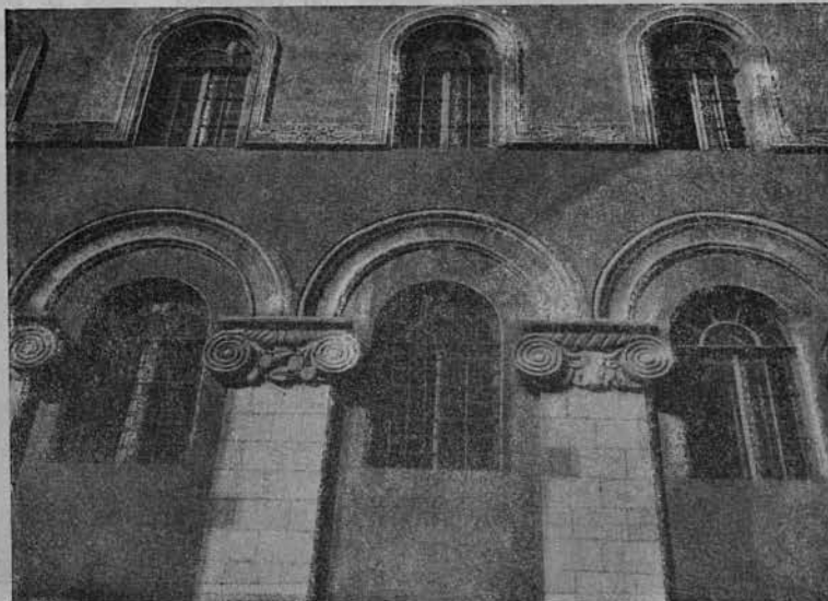
Пилястры бокового фасада
