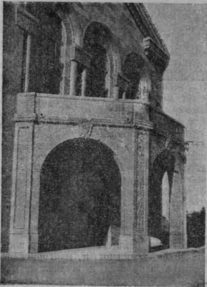
Вход в здание
