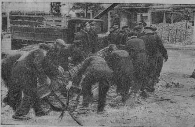
Варшава. Учащиеся на строительных работах
