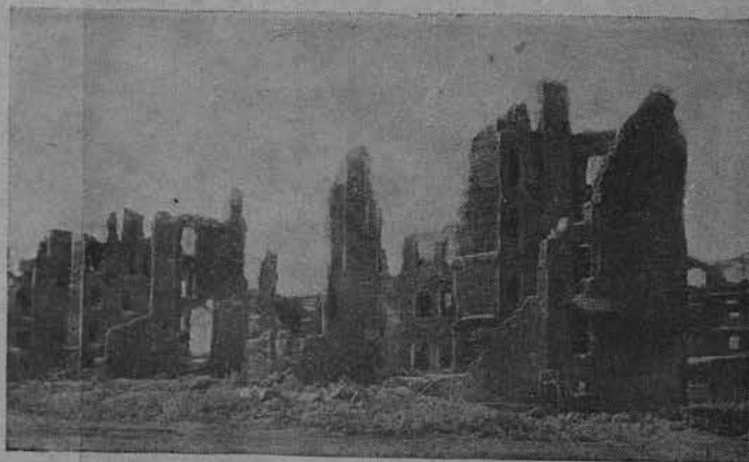
2. Разрушенные кварталы Северного поселка
