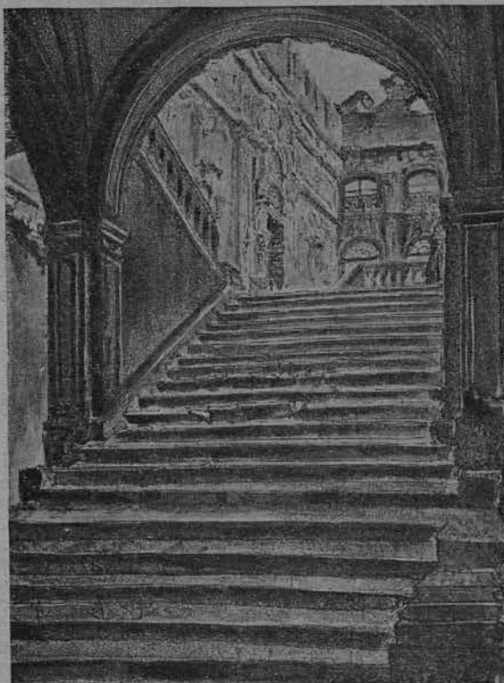
Лестница Екатерининского дворца в гор. Пушкине (Царское Село) после разрушения
