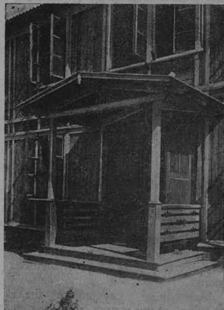
10. Фрагмент входа дома (тип Ш-2)
