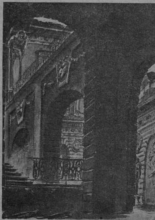
Вестибюль дворца в Павловске после разрушения
