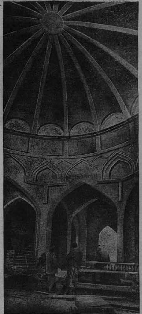
Центральное купольное фойе во время строительства
