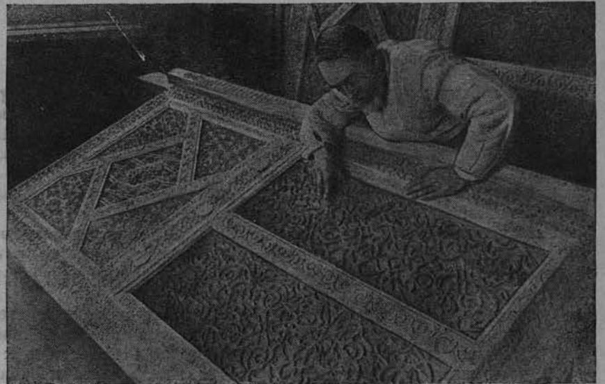
Изготовление резной двери для главного входа
