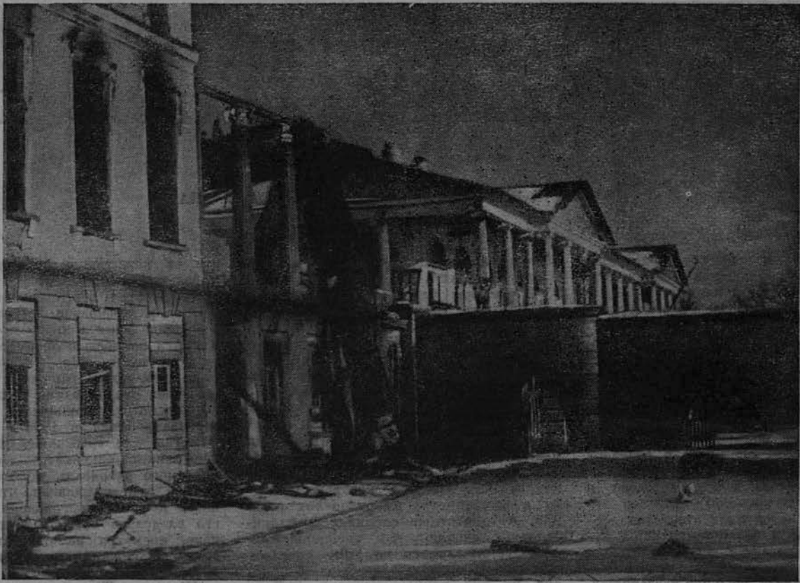
Гор. Пушкин (Царское село). Разрушения Камероновой галереи
