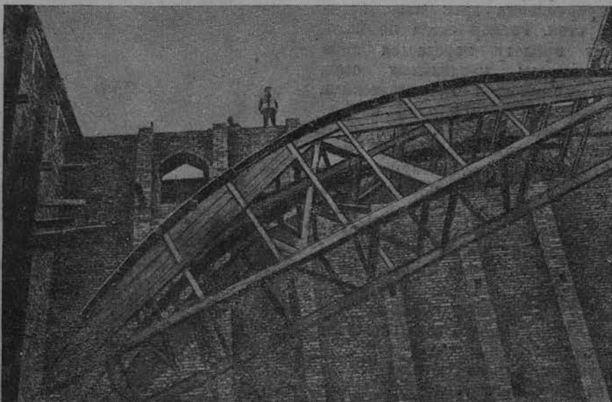
Подъем передвижной опалубки для кладки тонкостенного свода над сценой
