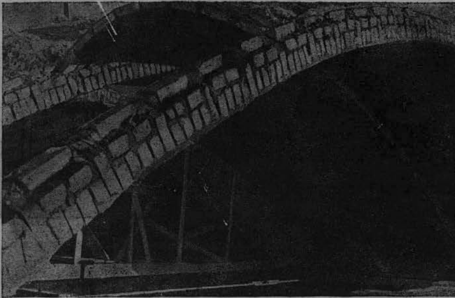
Деталь тонкостенного кирпичного свода над сценой
