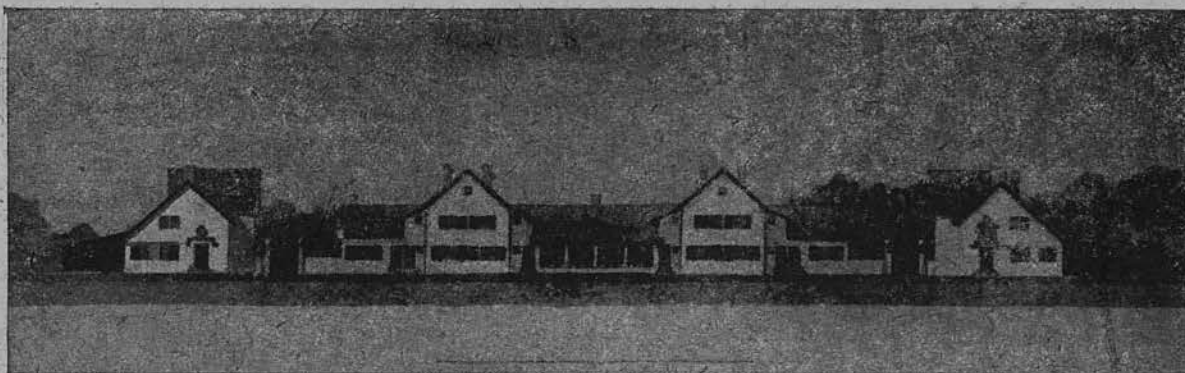
Фасад блочного дома на 20 квартир
