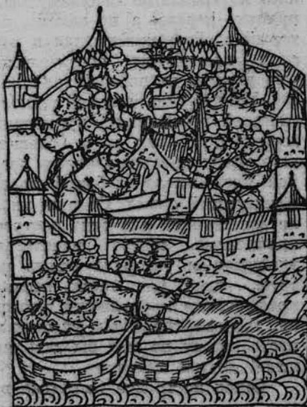
Постройка Свияжска. На первом плане — выгрузка доставленных по Волге строительных деталей, на втором — сборка городских укреплений и отдельных зданий. Со старинного рисунка
