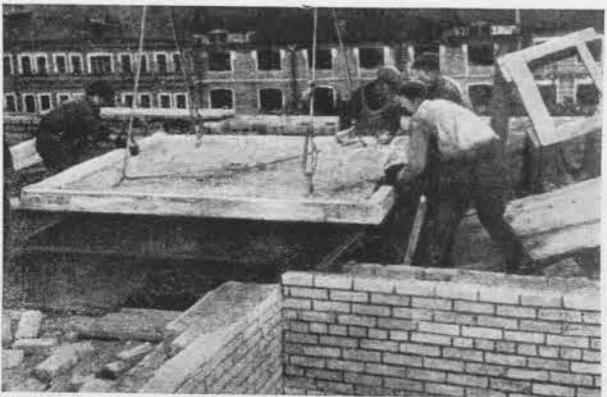
Укладка плиты санузла, поданной башенным краном
