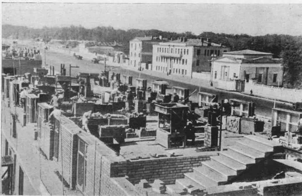
Общий вид кладки этажа. Оконные блоки и лестничный марш установлены до кладки. На фото видны контейнеры с кирпичом и бункера с раствором
