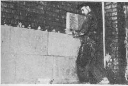
Внутренняя поверхность кирпичных стен со стороны квартиры обкладывается 5 см плитами диферент на алебастре
