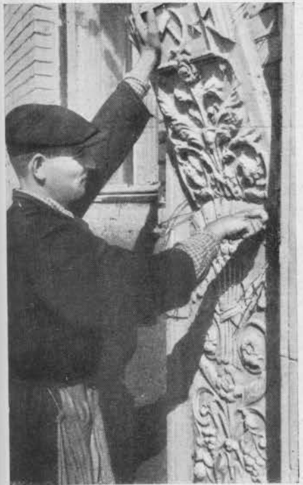
Установка плит наличников
