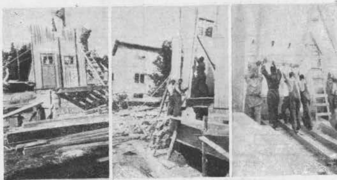
Монтаж щитового дома шведского типа
