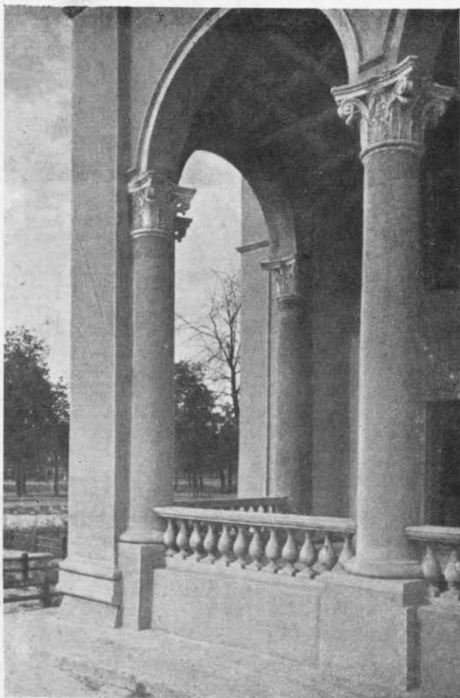
Жилой дом на Ленинградском шоссе. Лоджия
