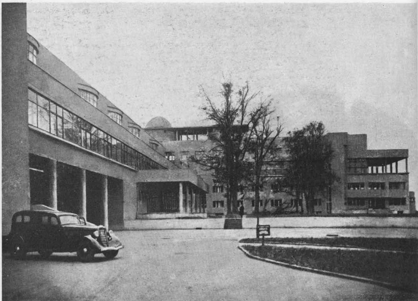
Л., В. и А. Веснины. Дворец культуры Пролетарского района г. Москвы. 1931—1933 гг. L., V. et A. Vesnine. Palais de la culture de l'arrondissement Proletarski à Moscou. 1931—1933
