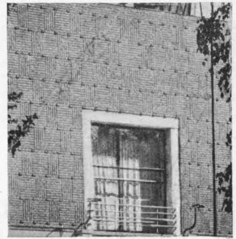
Фиг. 13. Узорная кирпичная кладка, имитирующая крупноблочную
