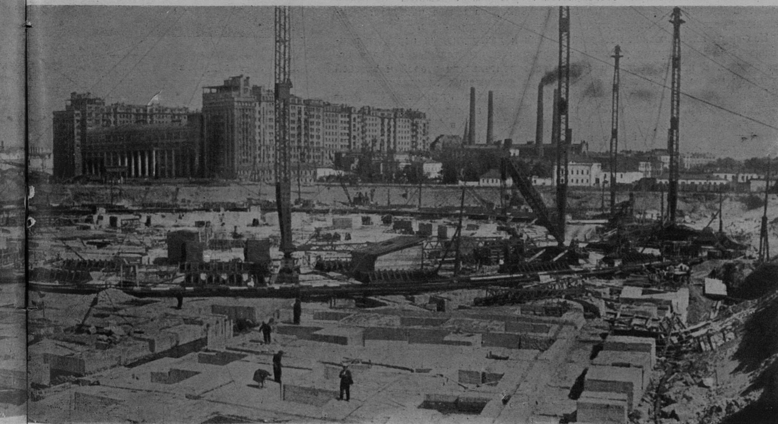
Palais des Soviets. Vue générale du chantier
