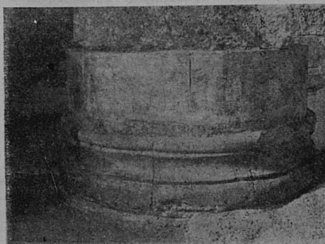
Колонна дворцового собора
