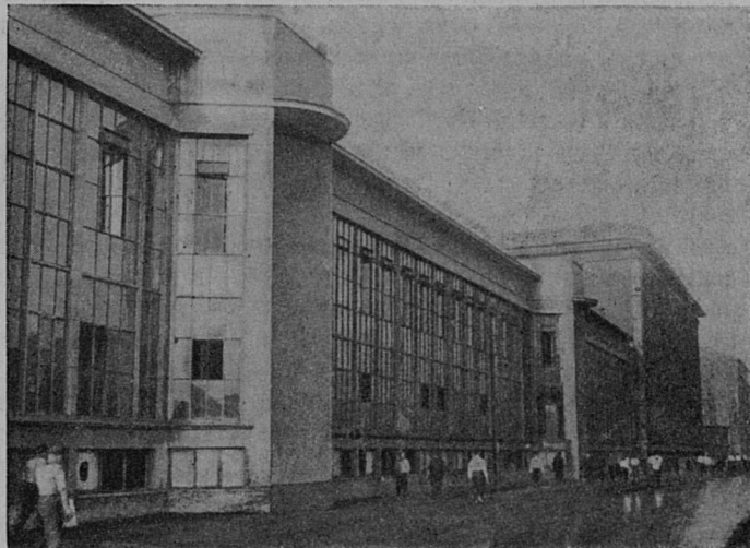
Застройка магистрали завода им. Сталина
