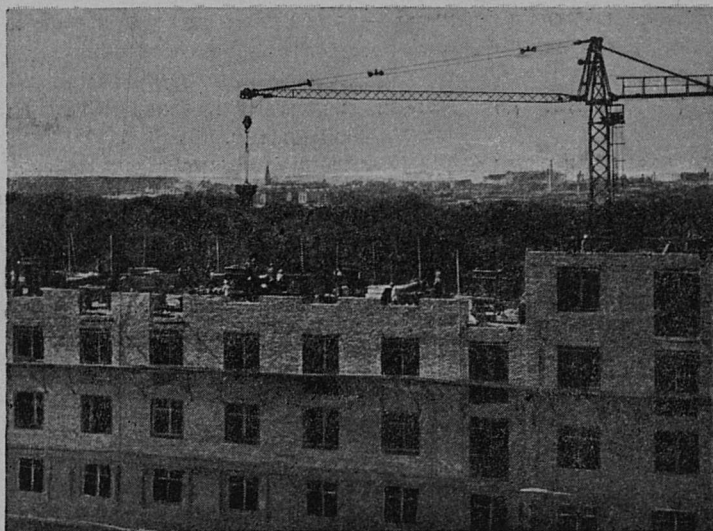
Корпус № 5 — кладка стен 4-го этажа
