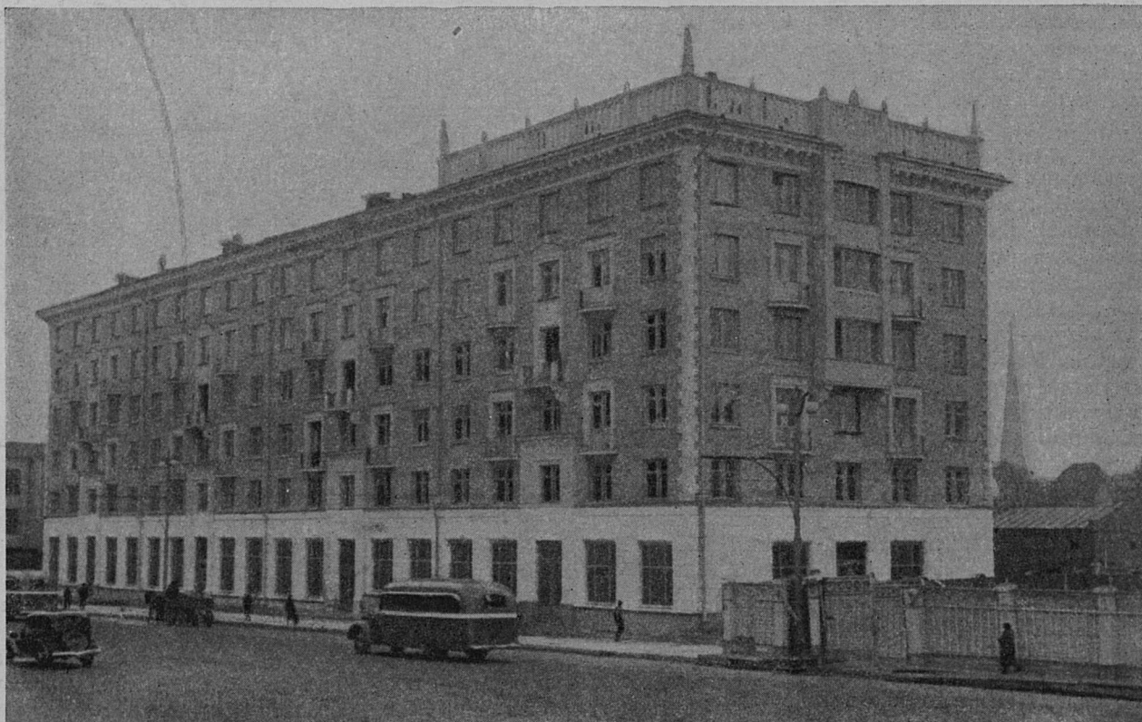
Скоростное строительство жилых домов на Б. Калужской улице в Москве. Корпус № 11 Construction accélérée des maisons d'habitation rue Grande Kaloujskaïa à Moscou. Bâtiment № 11
