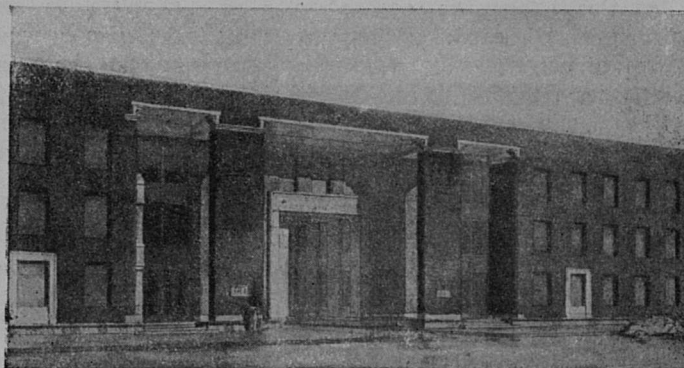
Заводоуправление и инженерный корпус автозавода КИМ Арх. Б. П. Штивель
