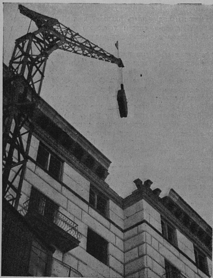
Строительство жилого дома из крупных блоков на Велозаводской улице Construction d'une maison en blocs artificiels rue Vélozavodskaja
