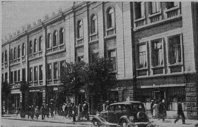
Сталино. Здание городского совета после реконструкции
