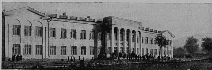
Школа на ул. Куйбышева Арх. Покровская
