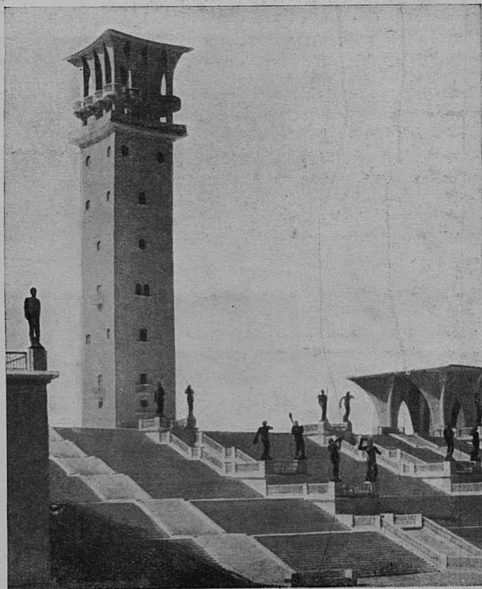
Главный вход Фрагмент
