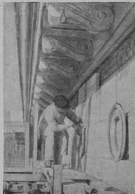
Процесс монтажа цементных деталей на строительстве жилых домов по ул. Горького в Москве
