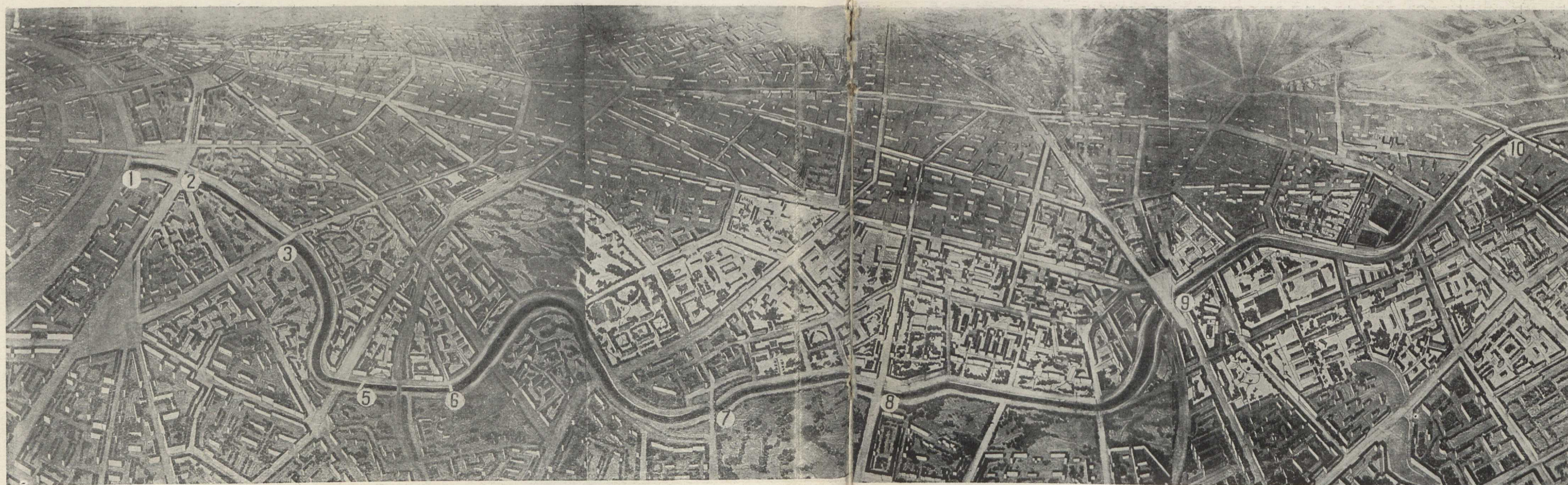
Панорама реки Яузы с строительством новых мостов Арх. К. Т. Топуридзе, Е. С. Сорокина, З. К. Овчаренко, Ю. С. Гребенщиков, техн. Н. Н. Иванова, А. Панфилова, Бригадир арх. И. В. Ткаченко
