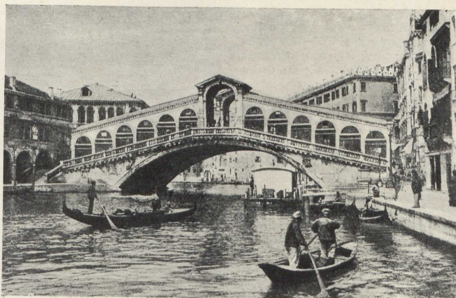
Venise. Pont du Rialto Arch. Antonio da Ponte
