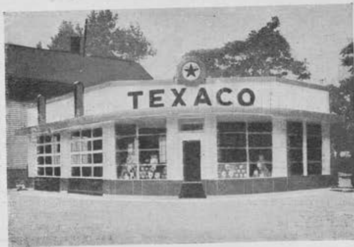
Service-station Texaco & Cleveland Vue générale
