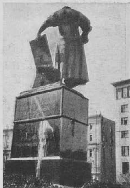
Потеки из трещин в камне памятника, реставрированного на цементном растворе (памятник Ивану Федорову в Москве)
