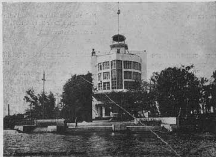
Водная станция «Динамо» Арх. Соколов
