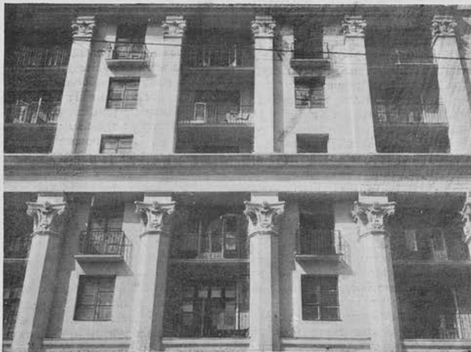
Отделка жилого дома известково-песчаной цветной штукатуркой
