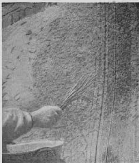
Выполнение штукатурки набрызгом „под шубу“
