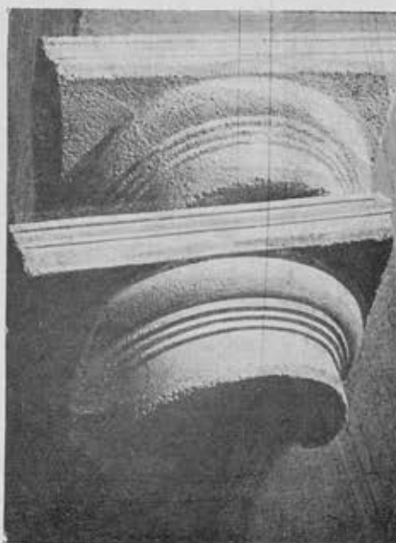
Образцы деталей из цветного бетона
