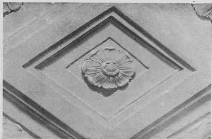
Détail du plafond du perron
