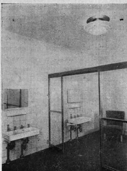
Рис. 8. Распределители воздуха в комбинации с осветительным устройством
