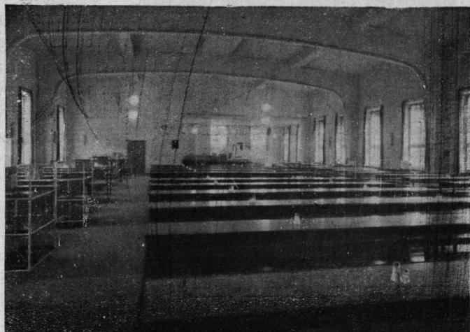
Рис. 7. Впускной канал, заложенный в продольном направлении по средине потолка (впуск воздуха через круглые отверстия на обеих вертикальных сторонах канала)
