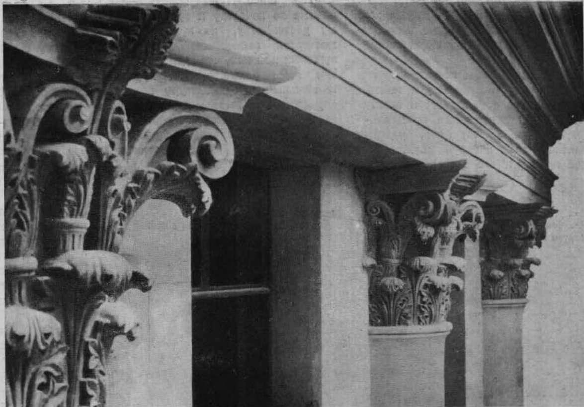
Fragment de la façade
