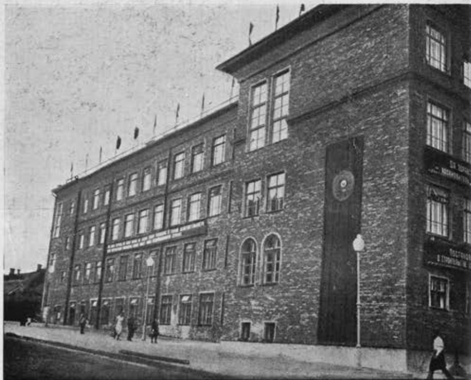
Школа на Б. Почтовой ул. в Москве Арх. М. И. Свиявский
