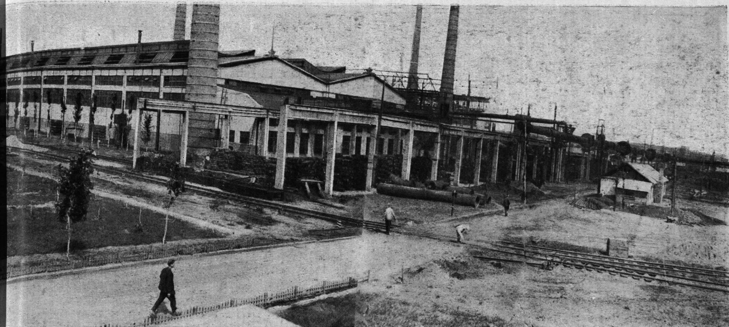
L'usine Kramatorsk. Voie magistrale
