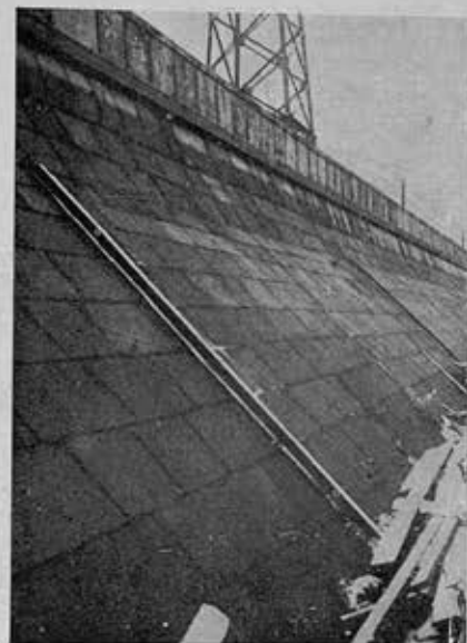
Облицовка участка набережной Parement de pierre d'une partie du quai
