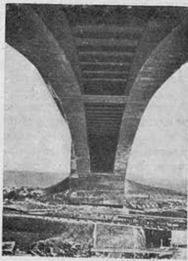
Кельн Мост через канал
