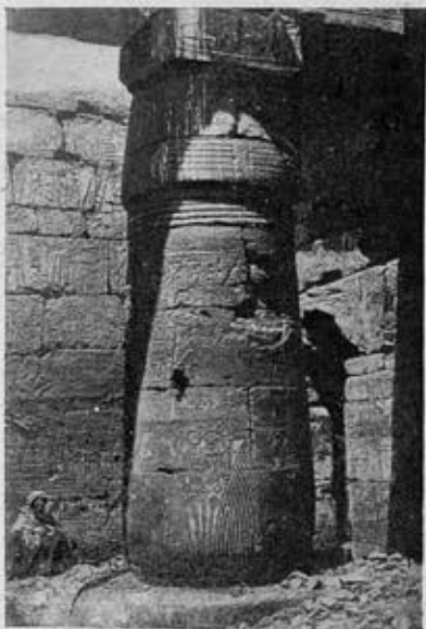
Колонна Карнакского храма Colonne du temple de Karnak
