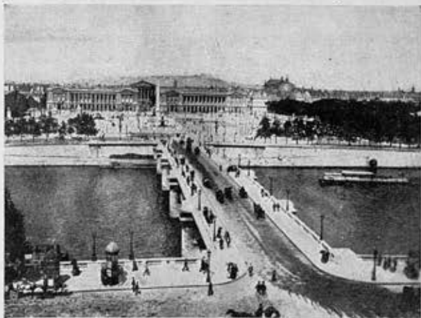
Рис. 9. Мост Согласия в Париже (1787—90), построенный Перроне 5 пролетов, от 25 до 31 м. На быках раньше были статуи
