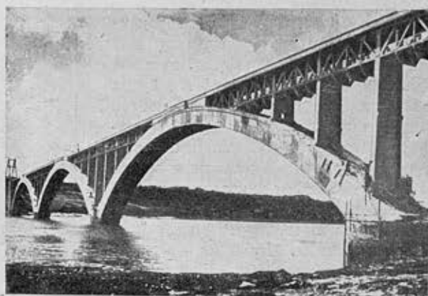
Рис. 29. Двухъярусный Элорнский мост во Франции (1927—31). Три коробчатые арки пролетами по 180 м. Поезд проходит сквозь замок арок (высотой 5 м). Проект Фрейссине, арх. Перре. Замечательная композиция, простая и изящная
