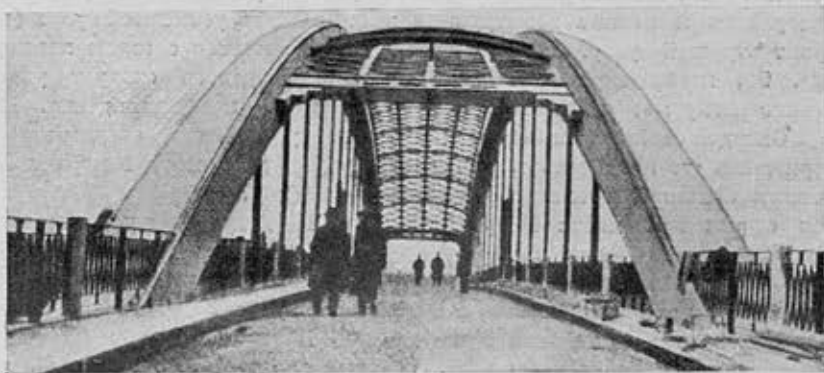
Рис. 25. Мост Конфлан у Парижа (1929). Пролет 126 м, ширина 7 м. Две коробчатых арки для жесткости соединены железобетонной сеткой. Трудный торцовый фасад решен удачно Pont Conflans près de Paris (1929)
