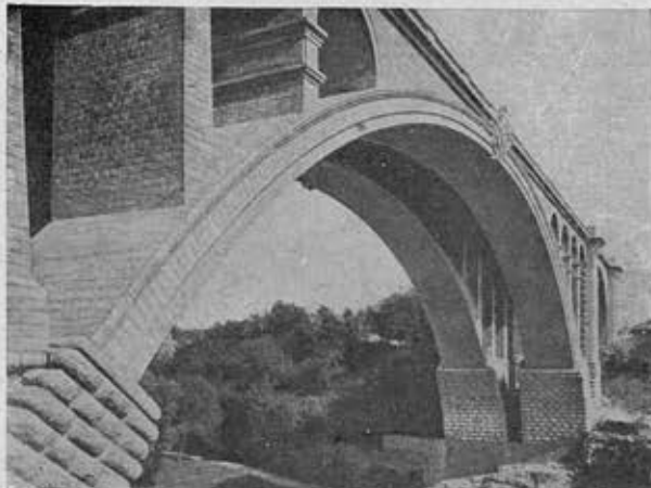
Рис. 12. Каменный мост в Люксембурге (1903). Пролет 85 м Проект Сежурне
