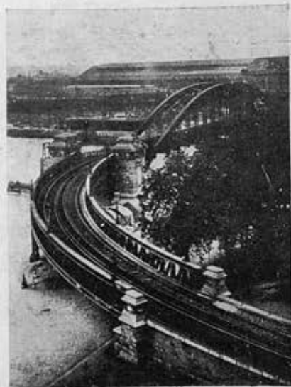
Рис. 15. Эстакада парижского метрополитена у Аустерлицкого моста (1904—05). Пролет арки 140 м. Фермы эстакады криволинейные в плане. Проект Резалья
