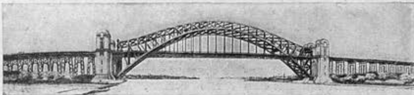
Рис. 21 и 22. Мост Гельгет в Нью-Йорке (1915), пролет 298 м под ж. д. Проект Лиденталя, арх. Горбестель. Форма двухшарнирной арки, приспособленная для удобства сборки, архитектурно не оправдана
