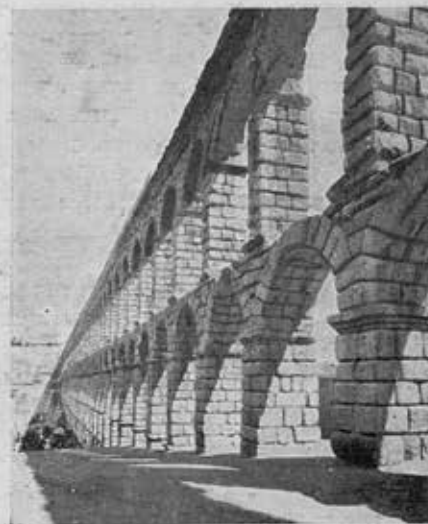
Рис. 14. Акведук в Сеговии (Испания). Высота 34 м. Верхние арки по 6 м
