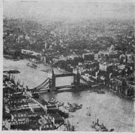
Рис. 3. Вид Лондона. Туэрский мост (1886—94) пролетом 82 + 61 + 82, висяче-разводной. При разведенном положении пешеходы идут поверху
