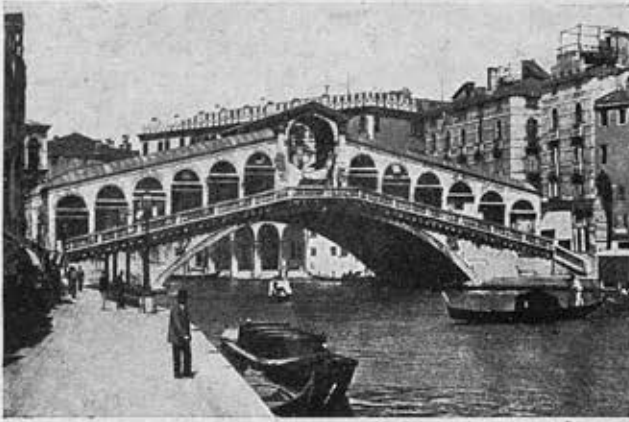
Рис. 5. Мост Риальто в Венеции (1587), построен Да-Понте из мрамора Пролет 28,5 м
