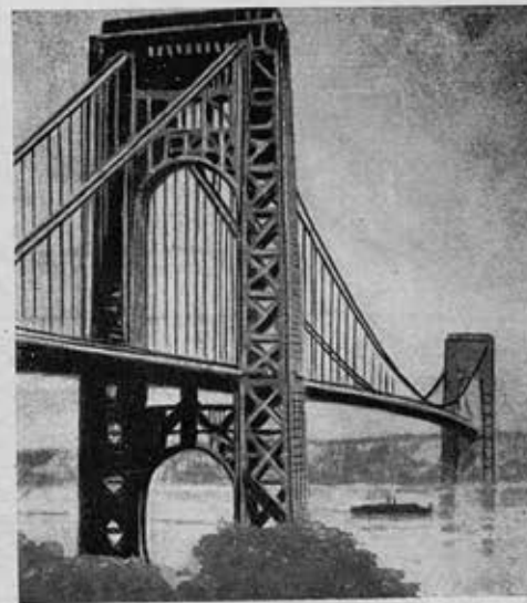
Рис. 16. Гудзонский мост в Нью-Йорке (1927—31). Пролет: 198 + 1067 + 198 м. Ширина 32,2 м, 10 рельсовых путей, высота двухъяр. полотна 12,3 м, диаметр канатов 91 см. Высота 172,5 м. Стоимость: 75 млн. долларов
