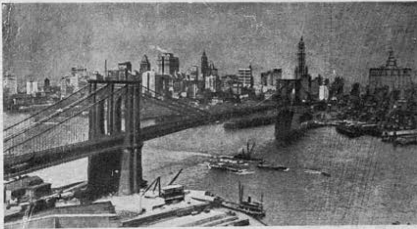
Рис. 2. Бруклинский мост. Двухпутное движение поездов электрической тягой в нижнем ярусе. Езда в обоих ярусах. Пешеходы — поверху
