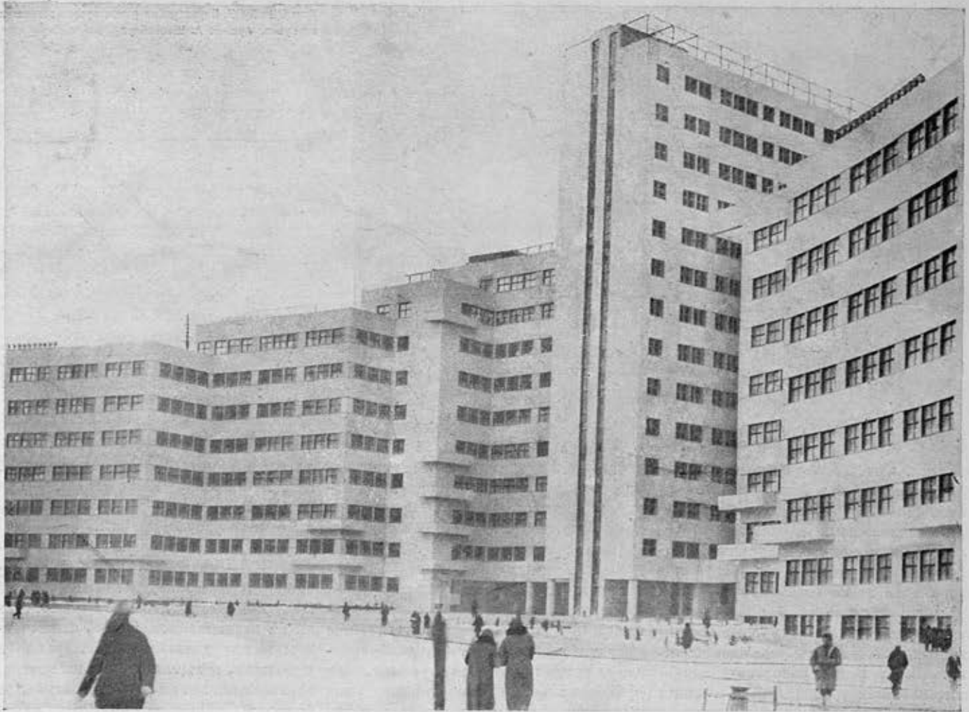
Дом проектных организаций в г. Харькове. Строительство начато в 1930 г. и в основном закончено к октябрьским торжествам 1933 г. Авторы проекта — проф. С. С. Серафимов и арх. Зандберг. Основные строители — инж. Шейер, инж. Медведовский и арх. Вельчиков. Кубатура сооружения 282 000 куб. м. Конструкция — железобетонный каркас с заполнением ракушечным камнем, перекрытия в основном железобетонные
