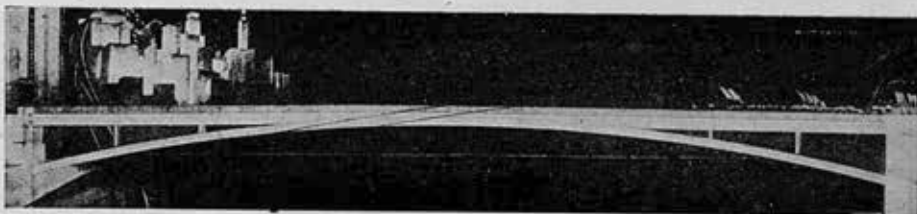
Рис. 35. Проект моста у Дворца советов. Конструкция из сварных коробчатых железных арок. Пролет 115 м, подъем 1 : 17. Проект проф. Стрелецкого
