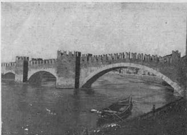
Рис. 7. Мост Капель Веккио в Вероне (1354). Пролеты: 12 + 24 + 48 Крепостной стиль, послуживший образцом для московского Кремля Pont Castel Vecchio à Vérone (1354)
