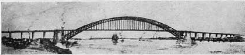
Рис. 20. Мост Кильванкул в Нью-Йорке (1928—32), пролет 510 м. Красивая форма двухшарнирной сквозной арки. Характерные для Нью-Йорка подземные эстакады Pont de Kilvankul à New-York (1928—32)
