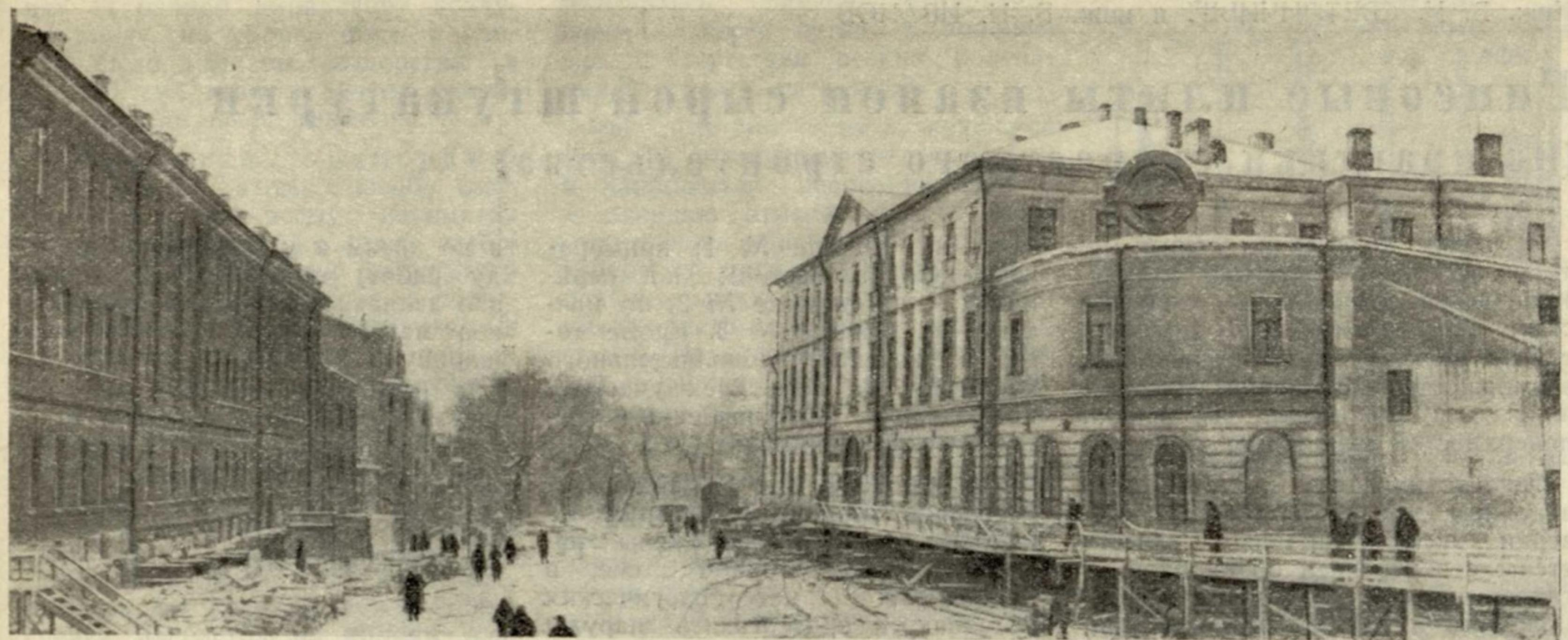
Рис. 13. Вид на переулок Садовских по окончании первого этапа передвижки. Справа — здание Глазной больницы, слева — ранее передвинутый с улицы Горького в глубь переулка дом № 61.
