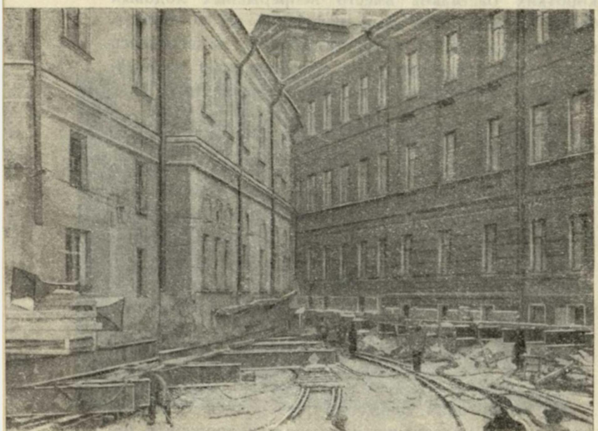
Рис. 11. Положение здания на шестой день передвижки. Справа — дом № 61 на ходовых конструкциях до его посадки на новый фундамент после передвижки.
