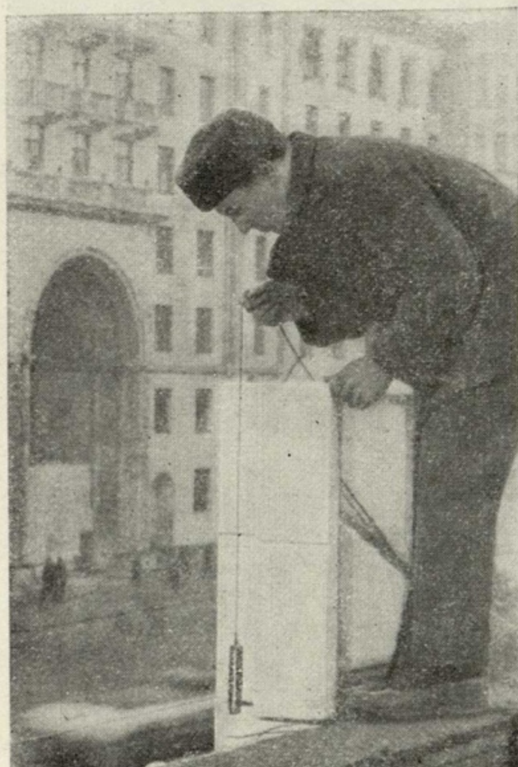
Рис. 5. Выверка положения облицовочных плит по вертикали.
