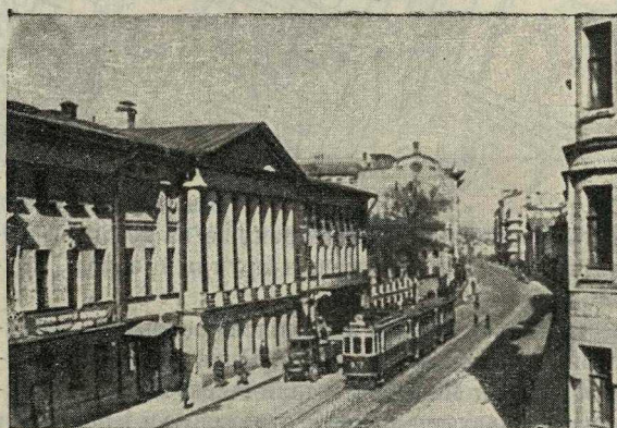
Дом № 32 по ул. Кропоткина, предполагаемый к перемещению вглубь двора.
