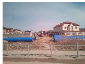
Строительство магистрального водовода от Чиркейского водохранилища Фото: Константин Шишов / Агентство стратегического развития «ЦЕНТР»
