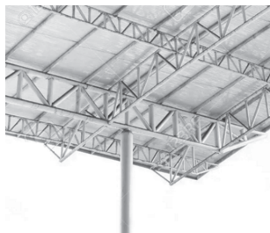
Пример исполнения стальная профильная фермы подиума
