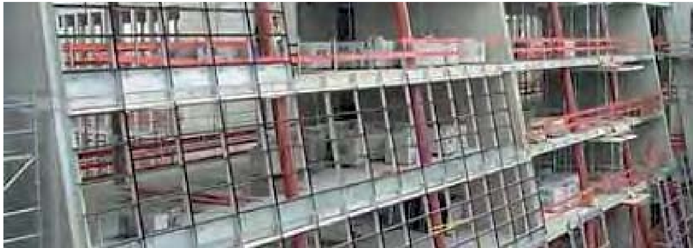
Пример системы стоечно-ригельного фасада
