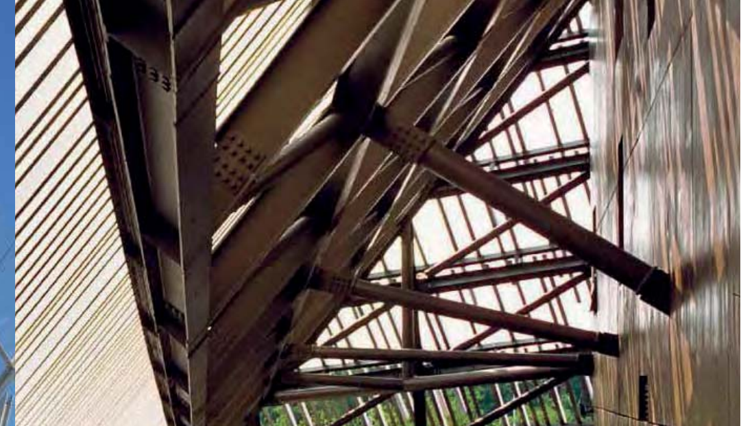
Соединительные балки с основной конструкцией внутри софита
